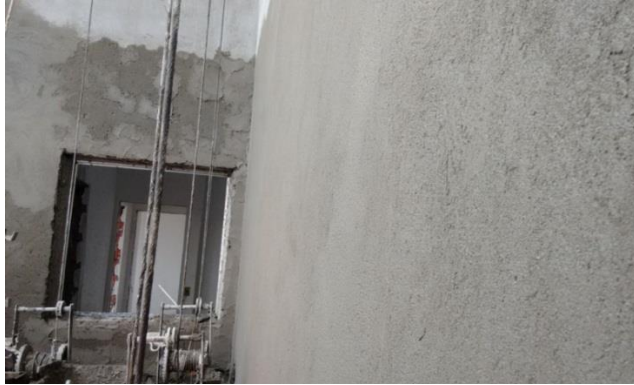
Figura 11: Execução do emboço.
