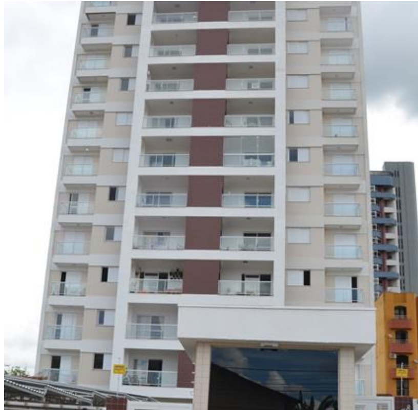
Figura 3: Edifício com revestimento cerâmico. Fonte: Arquivo Pessoal.
