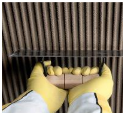
Figura 12: Aplicação da argamassa na base.
