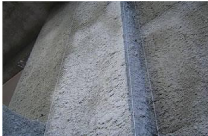
Figura 10: Chapisco convencional. Fonte: Arquivo Pessoal
