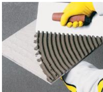
Figura 13: Aplicação da camada dupla.
