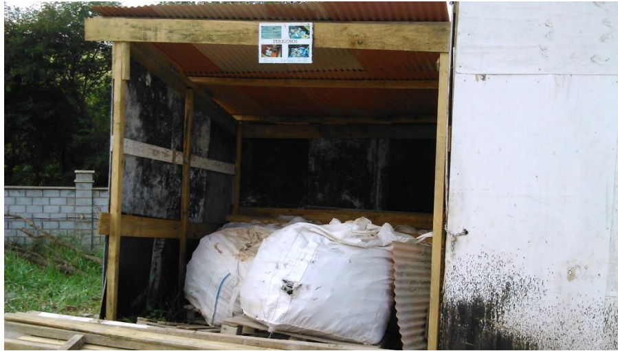
Figura 3: Baia de armazenamento dos materiais perigosos. Fonte: Arquivo Pessoal, 2016.
