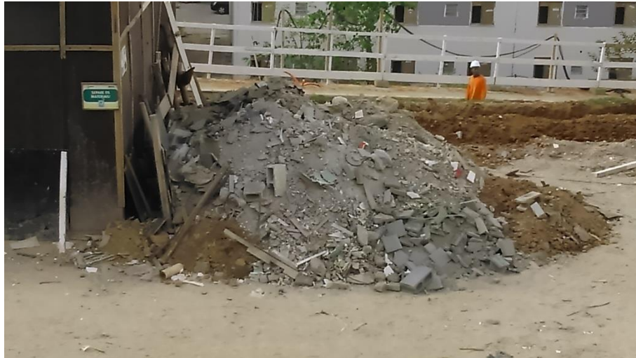
Figura 7: RCC, entulho Plaza Mayor. Fonte: Autor ,2016.
