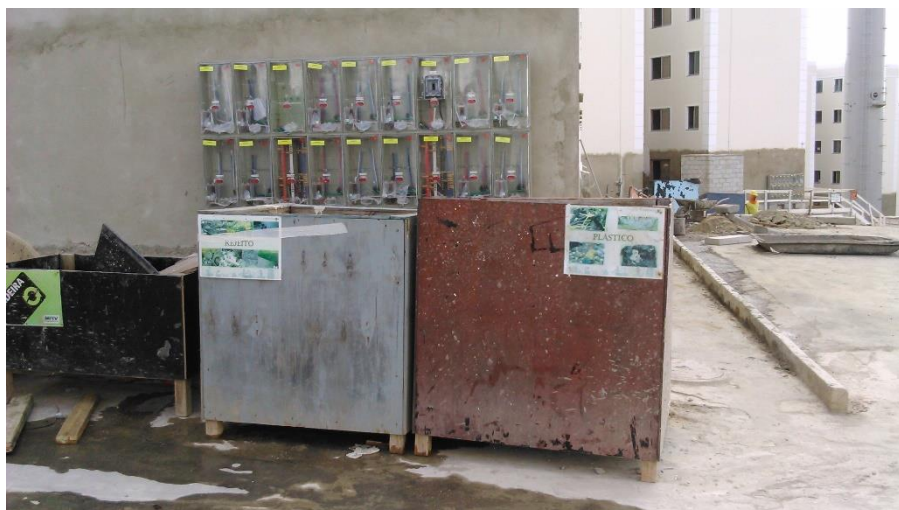
Figura 4: Caixas de segregação de RCC. Fonte: Arquivo Pessoal, 2016.
