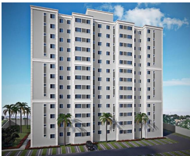
Figura 9: Fachada, Condomínio Spazio Treviso. Fonte: MRV, 2016.
