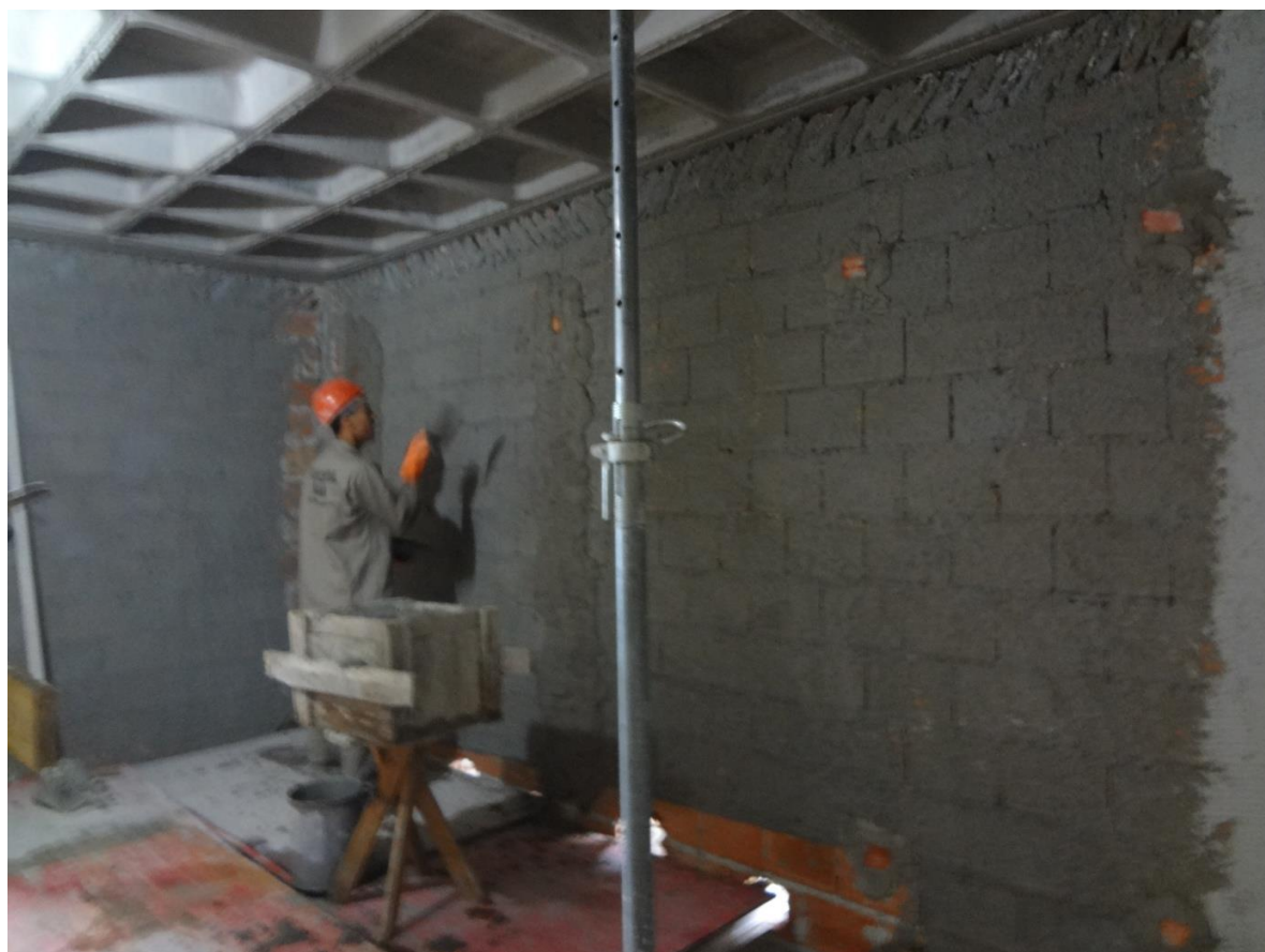
Figura 03 – Aplicação de Emboço em Alvenaria
