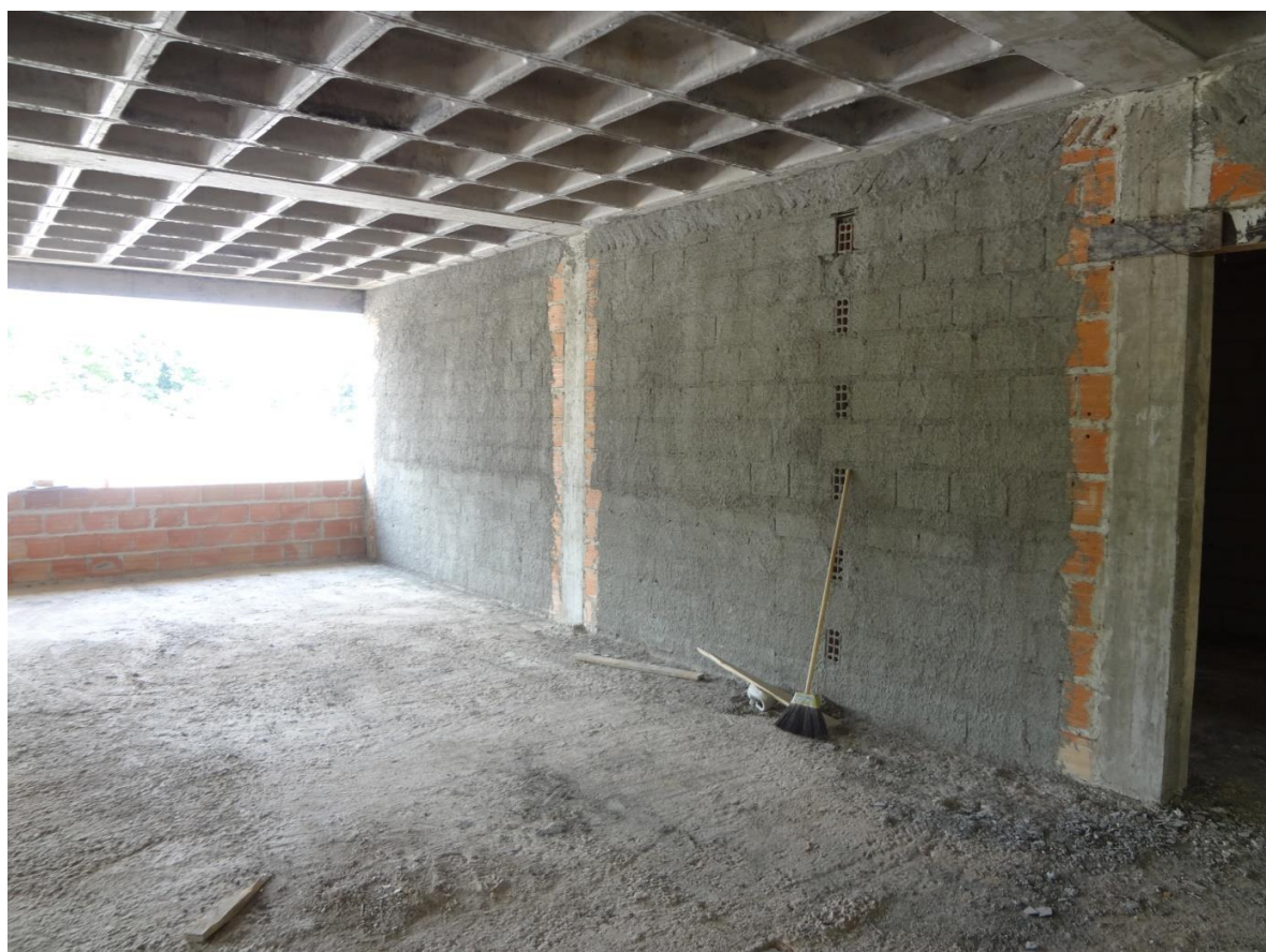
Figura 02 – Aplicação de chapisco
