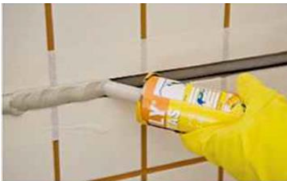
Figura 06 – Aplicação do selante
