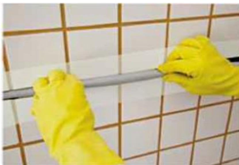
Figura 05 – Aplicação do limitador de profundidade
