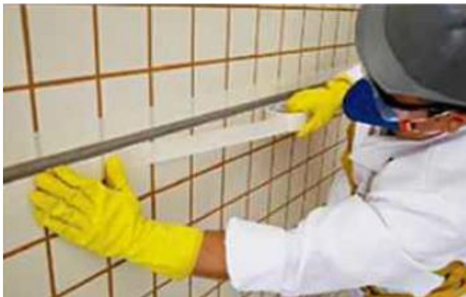
Figura 04 – Aplicação da fita autoadesiva
