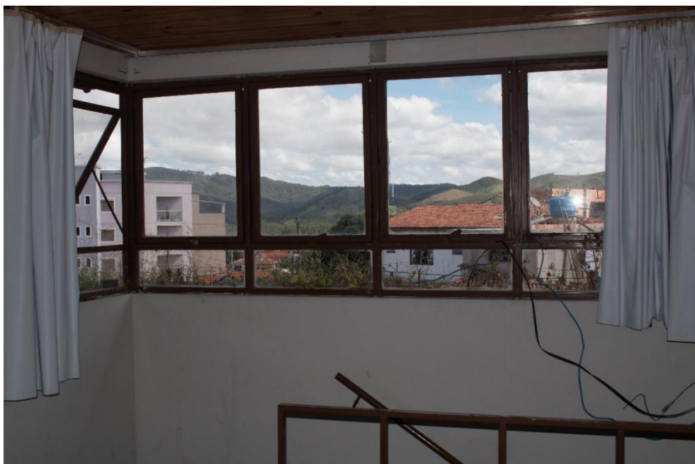
Figura 23 – Janela da sala do 2º andar (apto 201)
