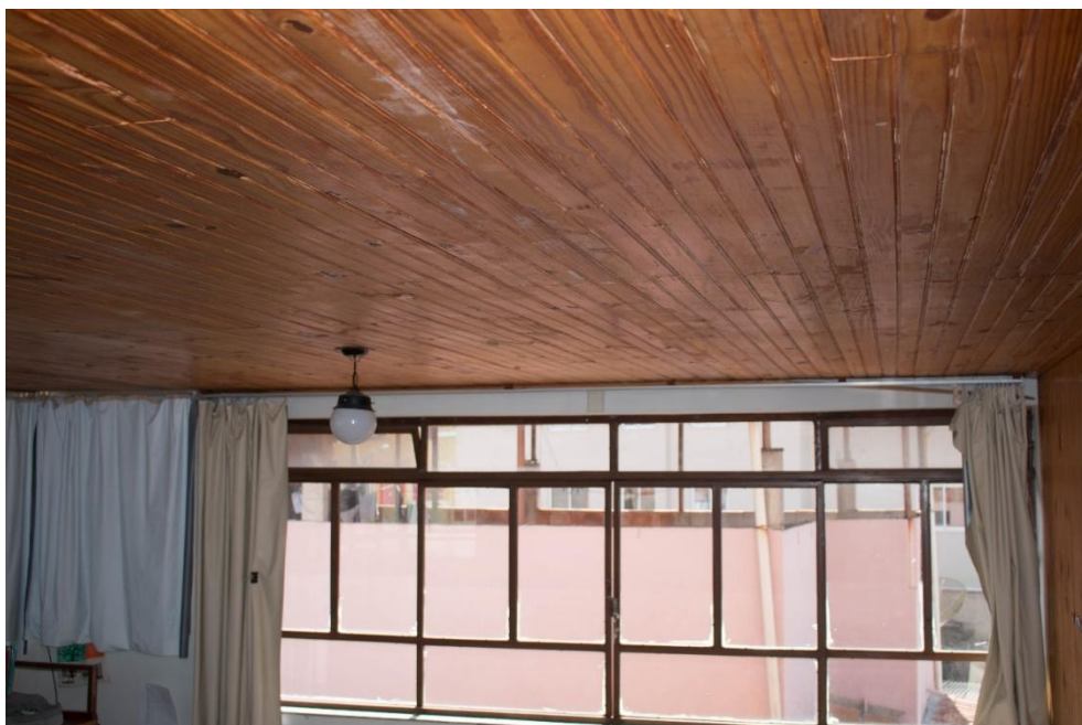
Figura 22 – Vista do forro de gesso e janela da sala do 2º andar (apto 201)
