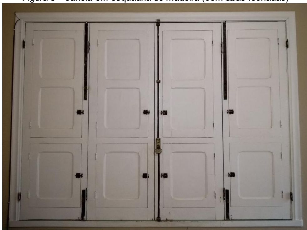
Figura 8 – Janela em esquadria de madeira (com abas fechadas)
