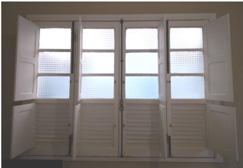
Figura 9 – Janela em esquadria de madeira (com abas abertas)
