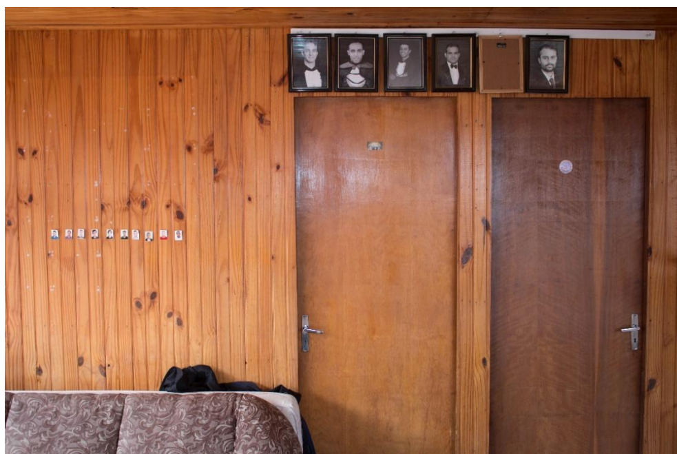
Figura 20 – Divisórias dos quartos em madeira
