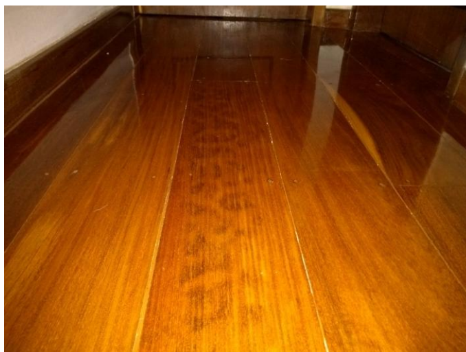
Figura 6 – Revestimento em madeira,
