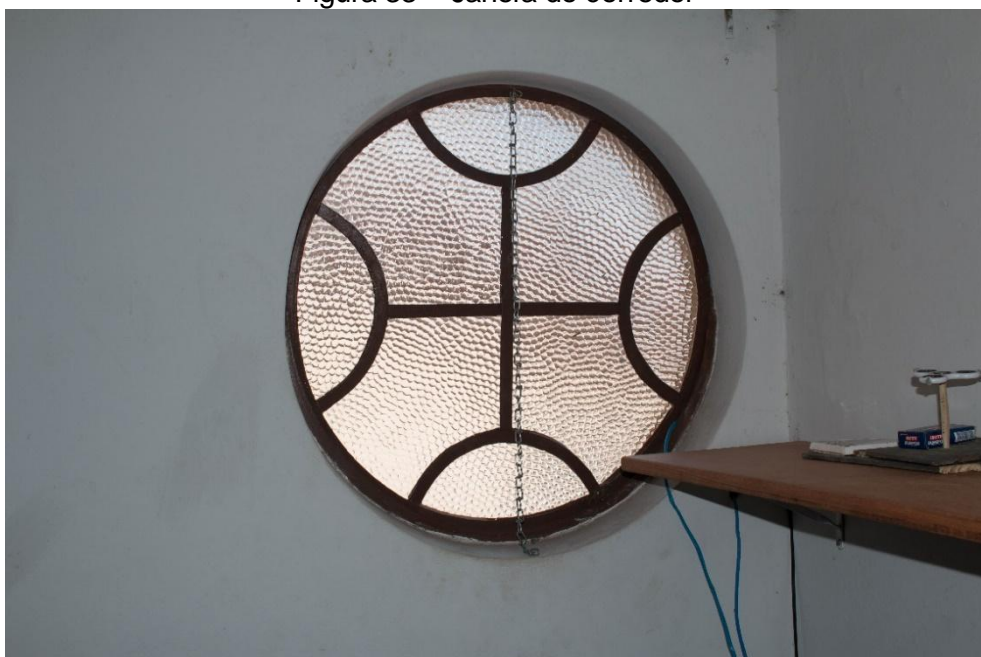
Figura 33 – Janela do corredor
