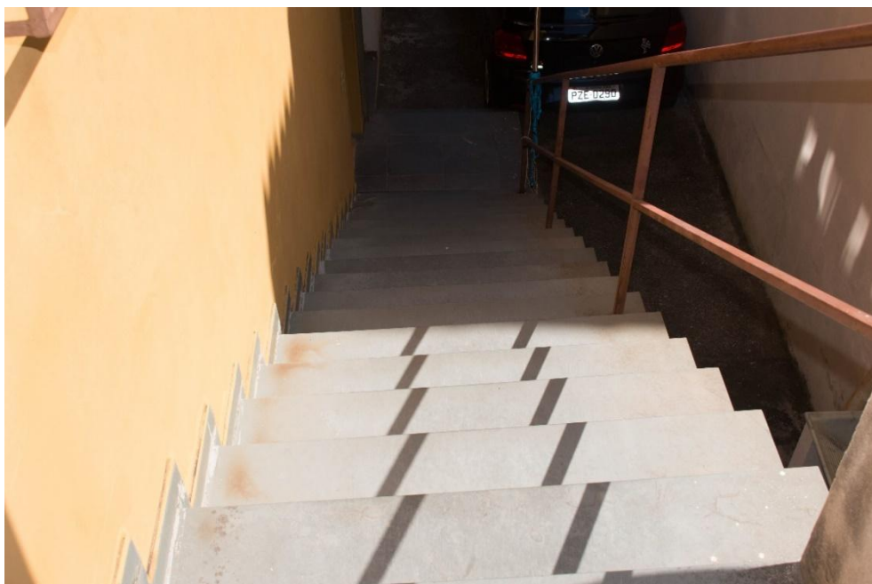
Figura 35 – Vista da escada externa
