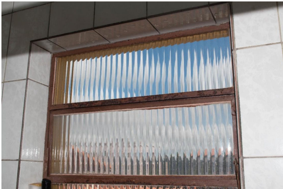
Figura 32 – Janela do banheiro
