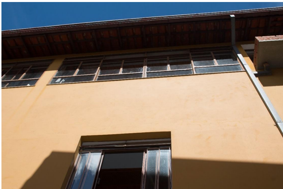
Figura 24 – Janela da sala do 2º andar e do 1º andar (apto 201) vista do exterior da casa
