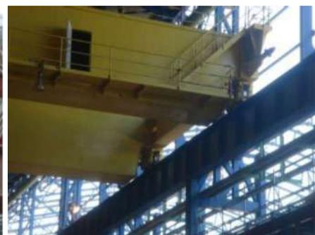
(c) Viga de rolamento suportando rodas de ponte rolante.
