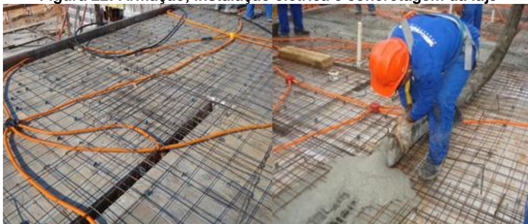
Figura 22: Armação, instalação elétrica e concretagem da laje
