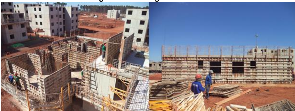
Figura 21: Montagem da forma
