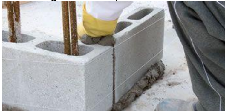
Figura 3: Marcação da alvenaria
