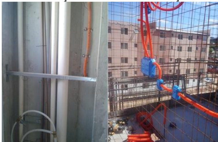
Figura 19: Instalações hidráulicas e instalações elétricas
