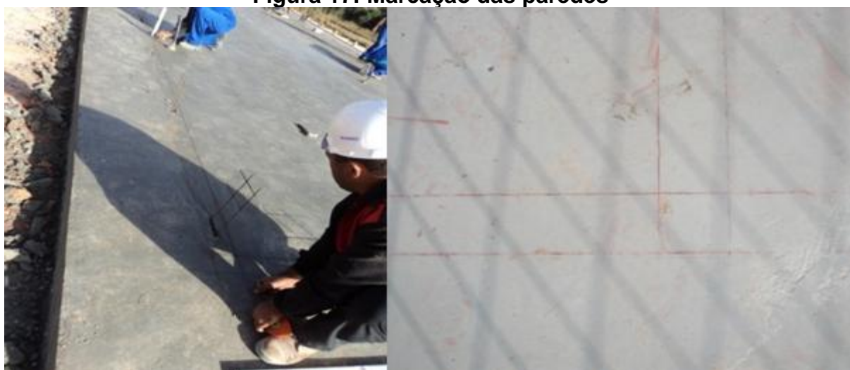
Figura 17: Marcação das paredes
