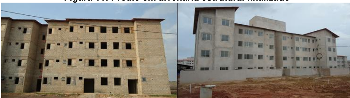
Figura 11: Prédio em alvenaria estrutural finalizado
