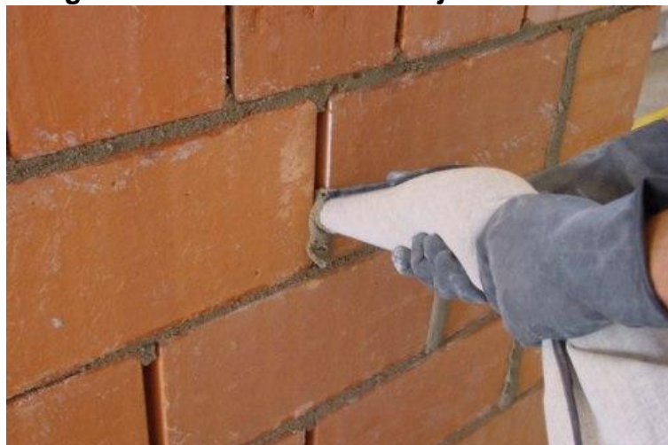
Figura 6: Preenchimento das juntas verticais
