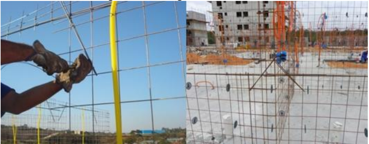
Figura 18: Montagem das armaduras
