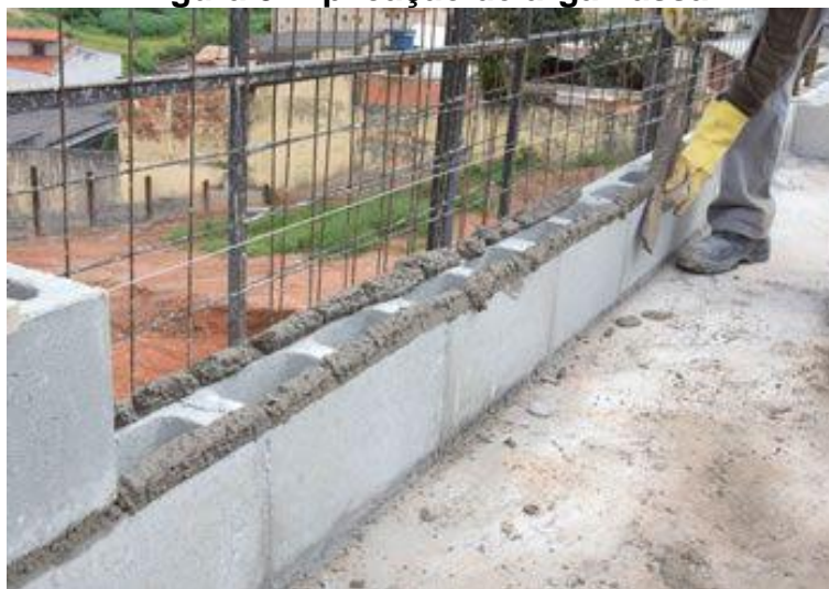
Figura 5: Aplicação de argamassa
