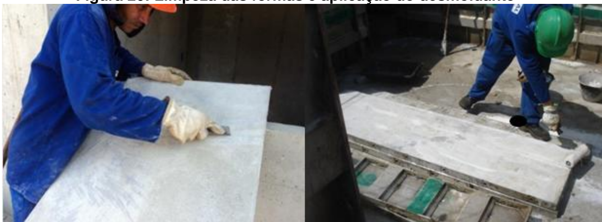
Figura 20: Limpeza das formas e aplicação do desmoldante
