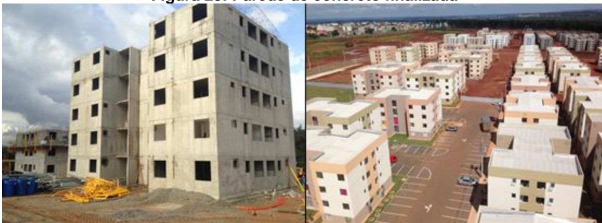
Figura 23: Parede de concreto finalizada
