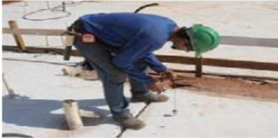
Figura 4.7: Marcação do posicionamento dos painéis.
