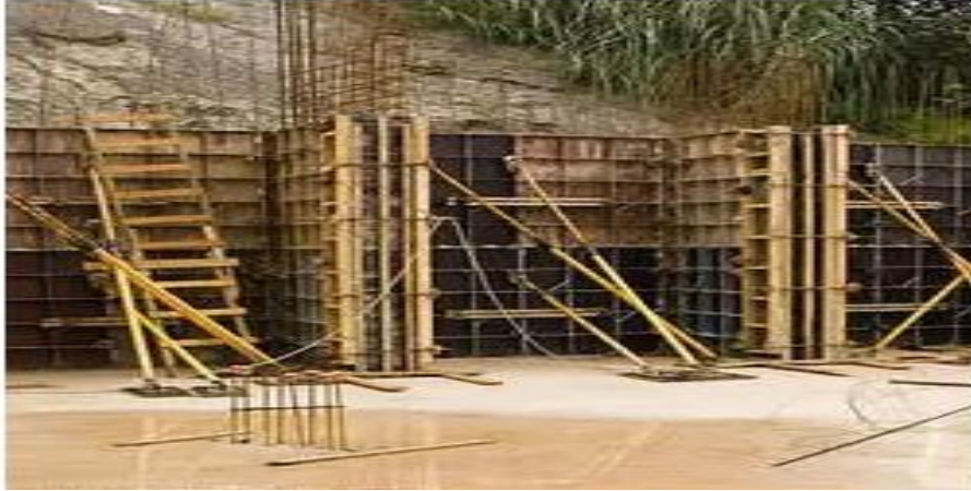
Figura 4.1: Fôrma em madeira para execução de parede de concreto.
