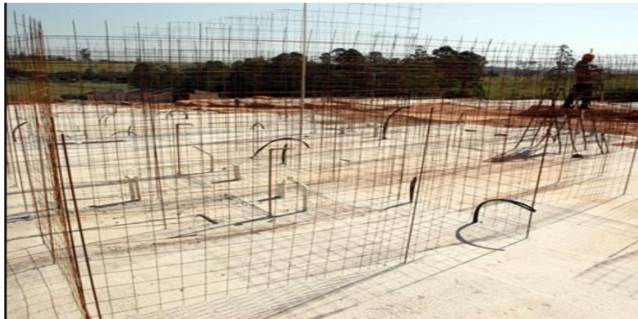
Figura 4.8: Execução de montagem de armaduras eletro soldadas para paredes de concreto.
