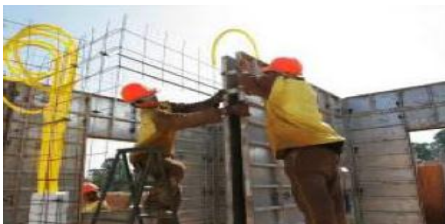
Figura 4.13: Montagem simultânea de painéis para parede de concreto.
