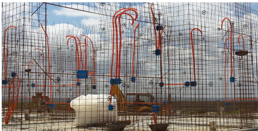
Figura 4.10: Montagem das instalações prediais e espaçadores nas armaduras.
