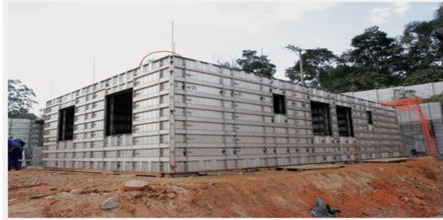
Figura 4.3: Execução de parede de concreto com formas metálicas de alumínio.
