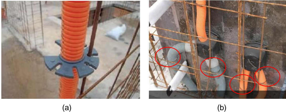
Figura 4.11: travamento das instalações (a) Por meio de espaçadores (b) utilizando arrame recozido. Fonte: (a) e (b) Comunidade da Construção (2015).
