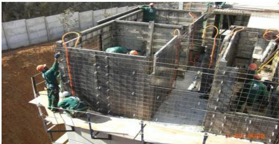
Figura 4.12: Montagem dos painéis internos de sistema de parede de concreto.
