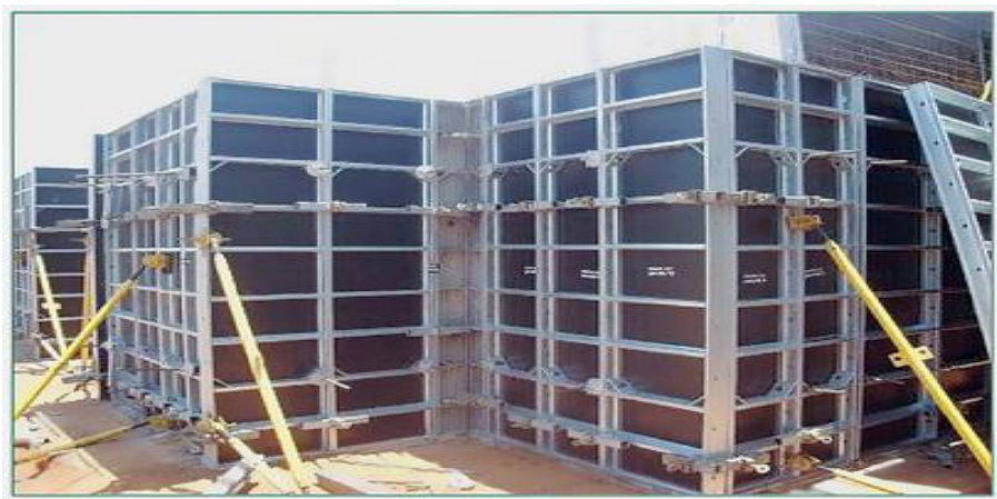
Figura 4.4: Fôrma composta com painéis compensados e quadros metálicos.
