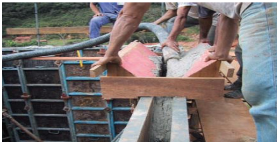
Figura 4.18:Utilização de funil para lançamento do concreto nas fôrmas.
