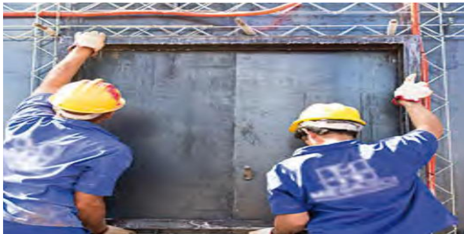
Figura 4.14: Montagem de gabarito para vão de janela.
