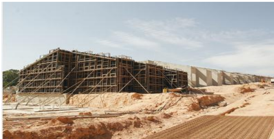
Figura 4.2: Execução de paredes de concreto com fôrmas plásticas.
