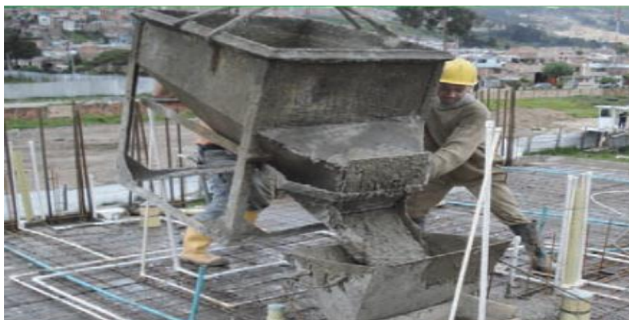
Figura 4.17: Transporte e lançamento de concreto com auxílio de depósito intermediário.
