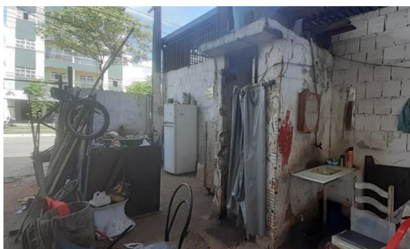
Figura 17 - Banheiro e cozinha em situações precárias
