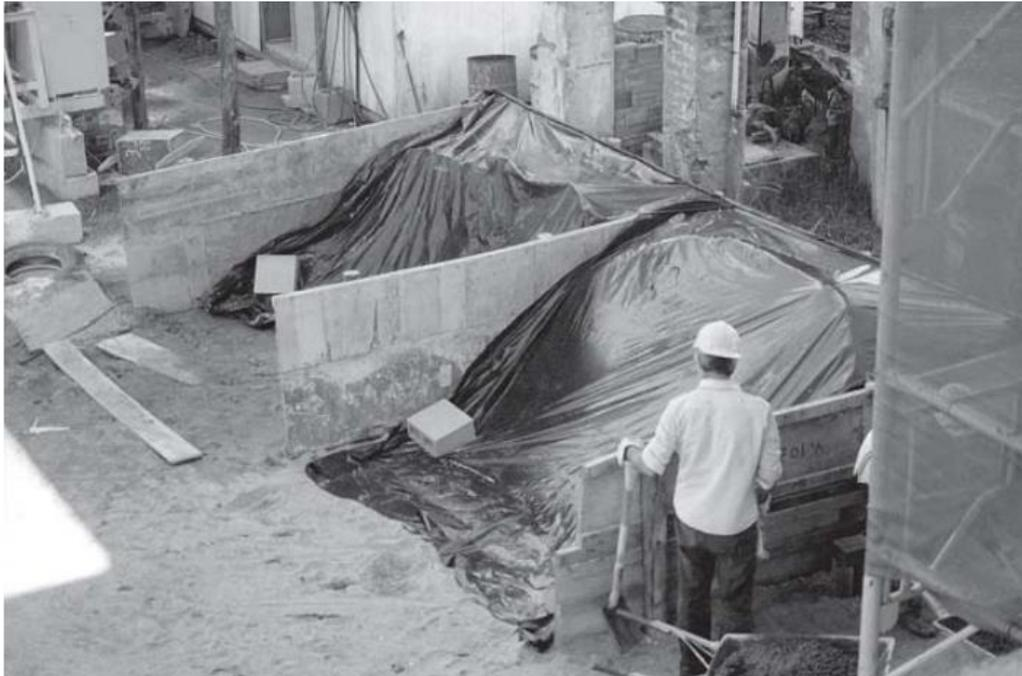
**Figura 4:** Contenções laterais e lona de cobertura em baia de agregados. Fonte: Saurin e Formoso (2006).
