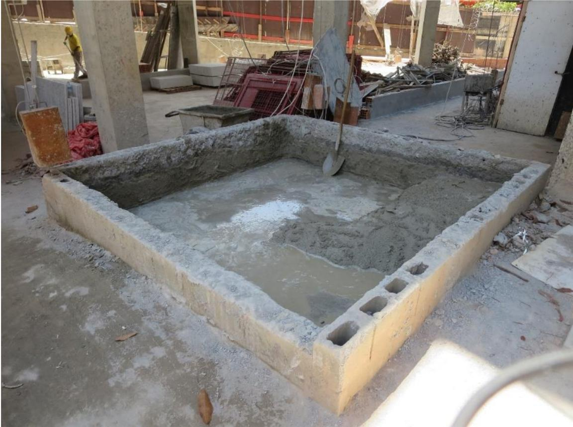
**Figura 18:** Baia de argamassa utilizada para armazenamento de concreto ou argamassa usinado. Fonte: Arquivo pessoal.
