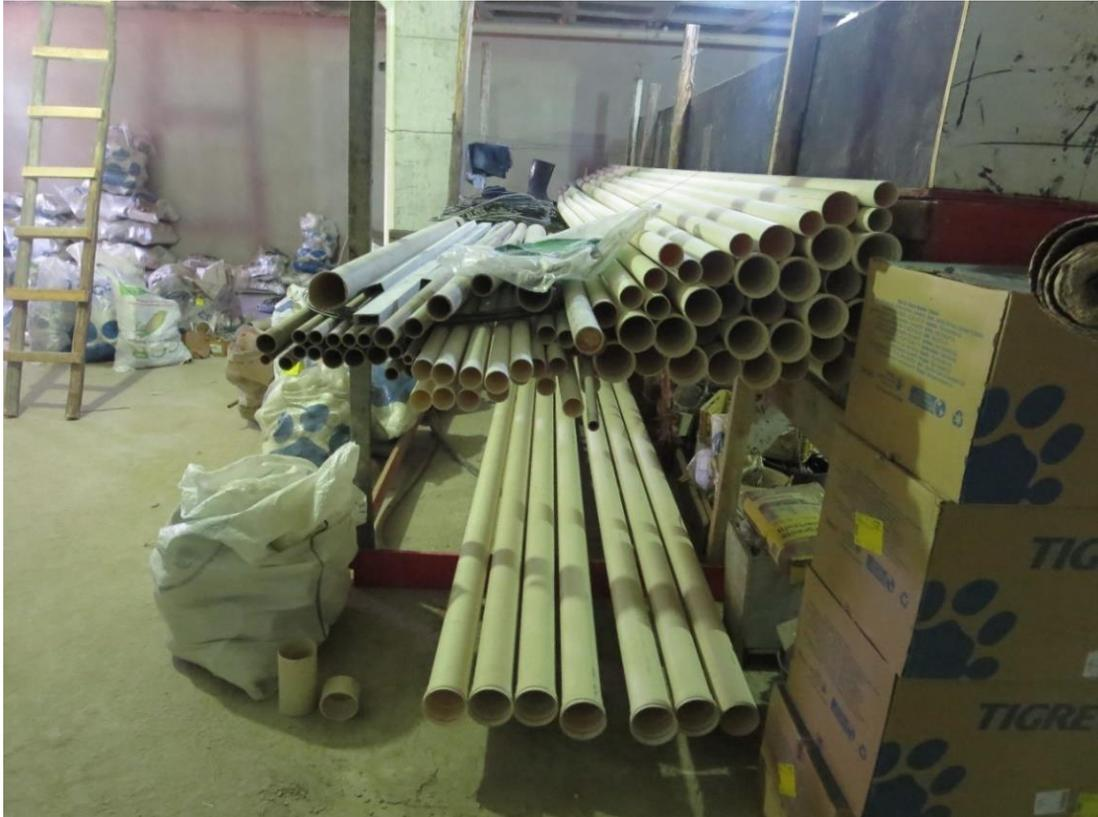
**Figura 13:** Armazenamento de tubos de PVC. Fonte: Arquivo pessoal.
