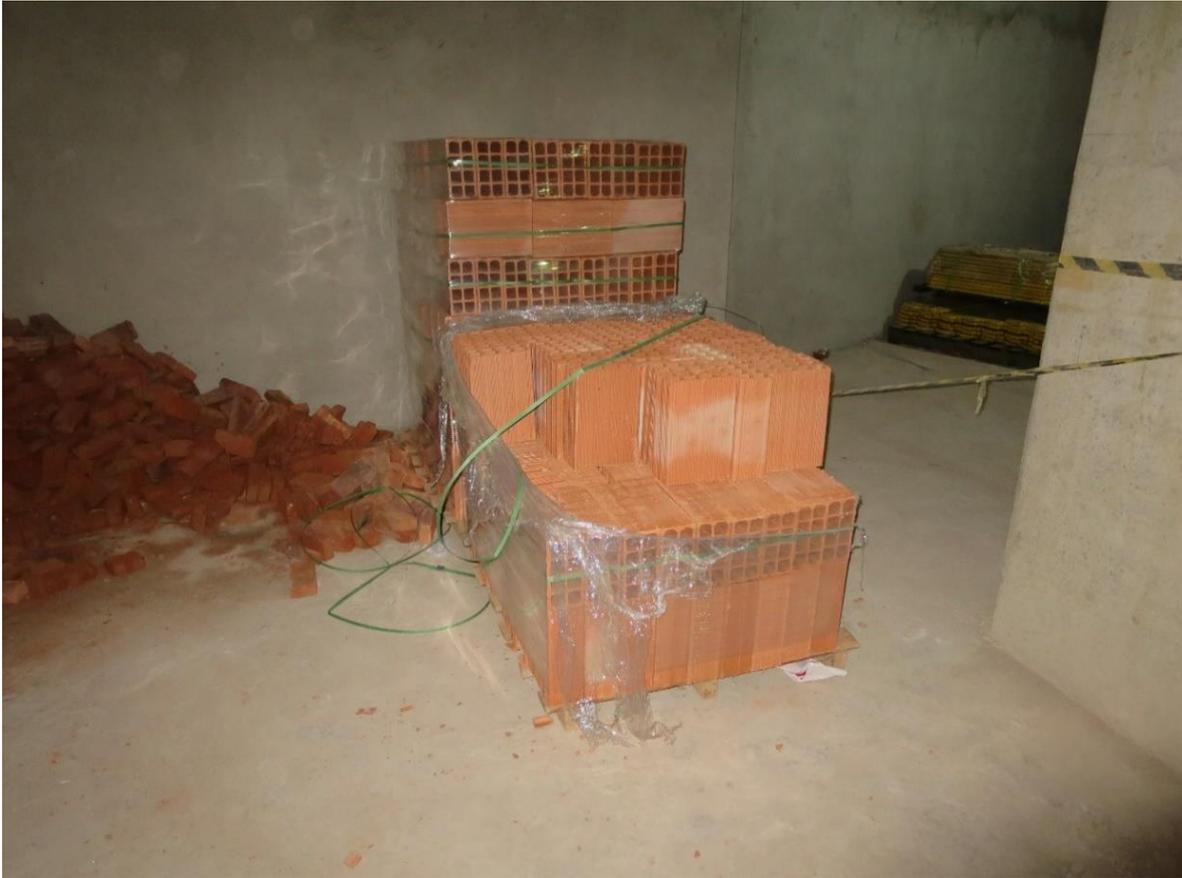
**Figura 19:** Armazenamento de blocos cerâmicos. Fonte: Arquivo pessoal.
