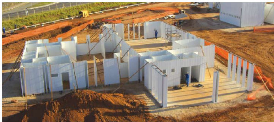
Figura 2 - Montagem e escoramento do perfis
