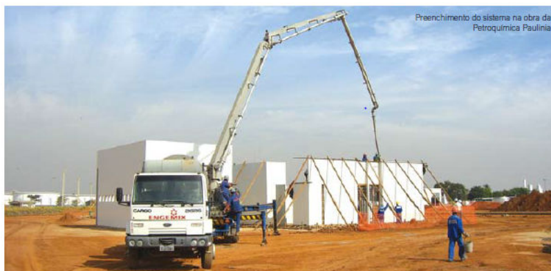
Figura 3 - Concretagem de uma casa com perfis de PVC com bombeamento
