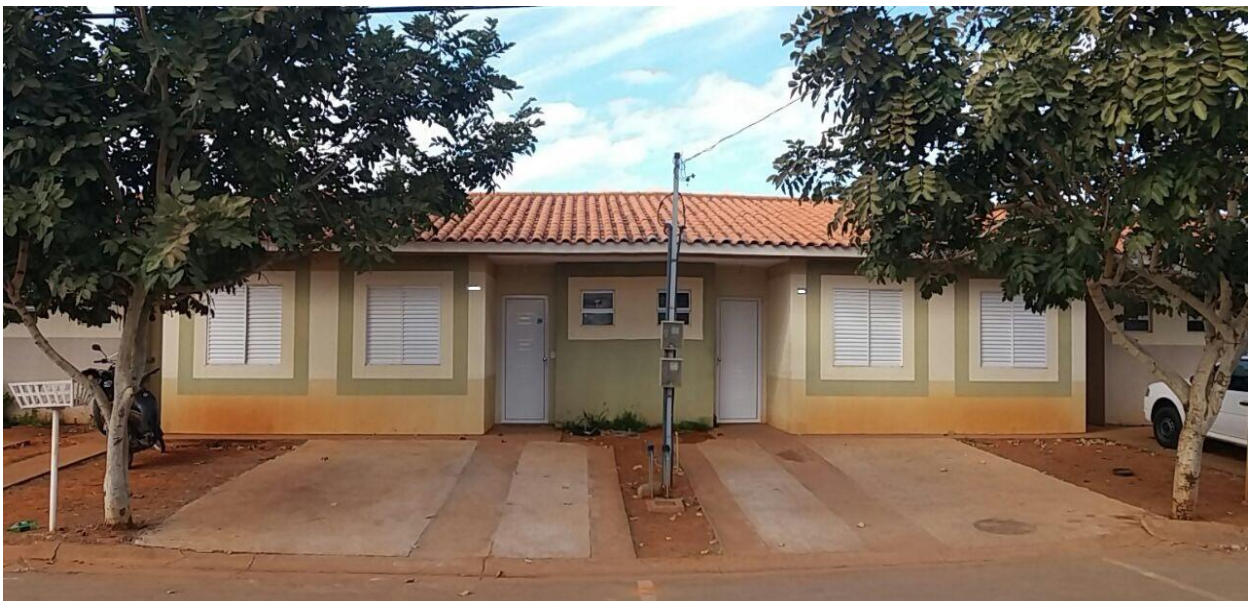
Figura 4.8 - Fachada Casa Fonte: Autora
