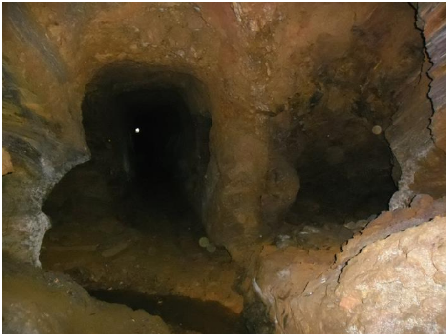
Figura 13: Área interna da galeria subterrânea antes de abrir para visita, ano de 2012.
