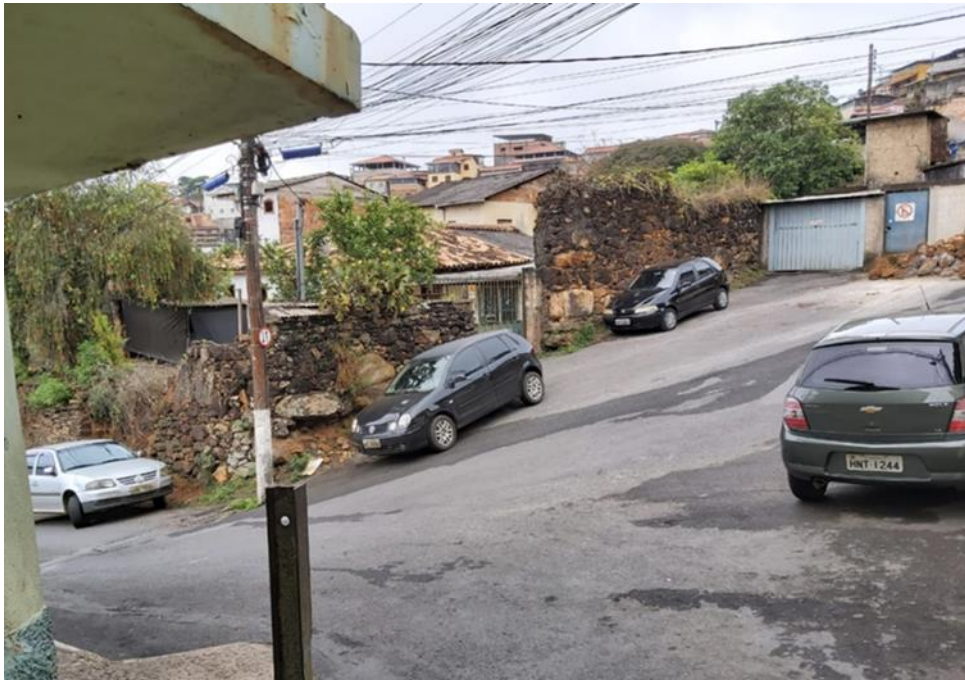
Figura 7: Casas dentro das estruturas de mundéus no Bairro São Cristóvão.
