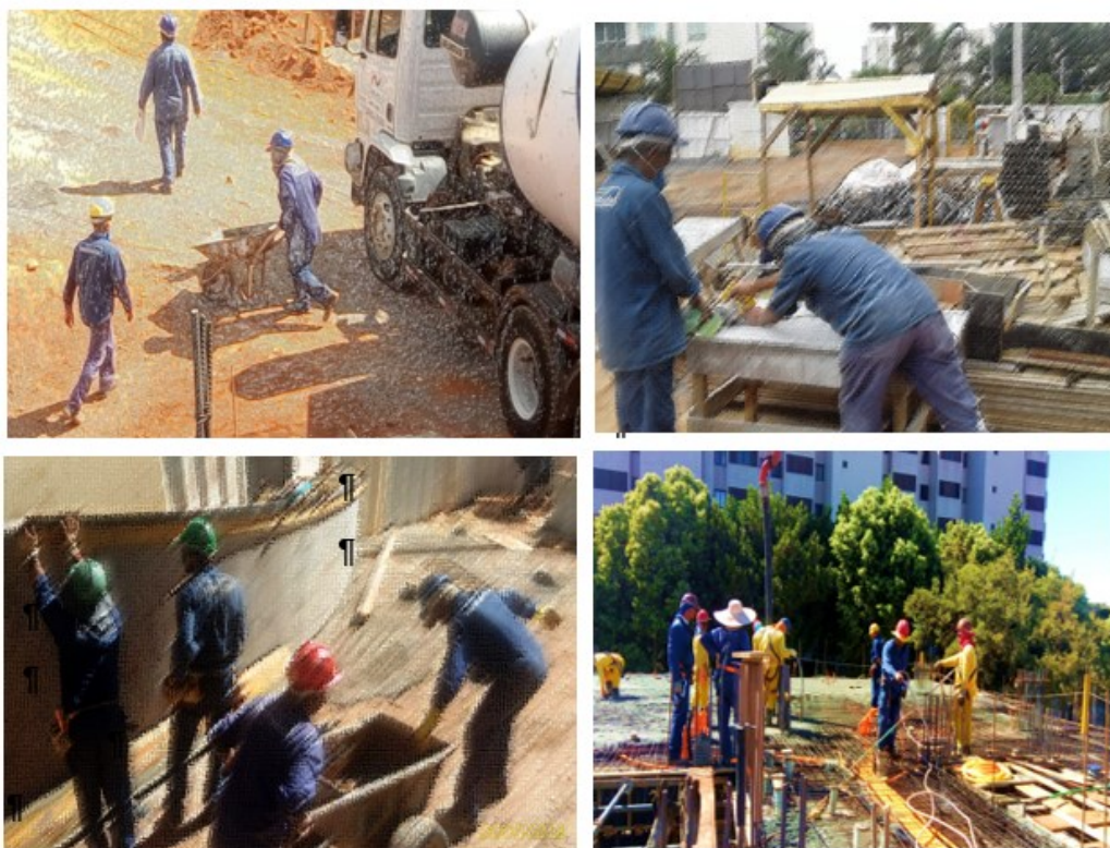
Figura 9 — Dinâmica do trabalho realizado no canteiro de obra
