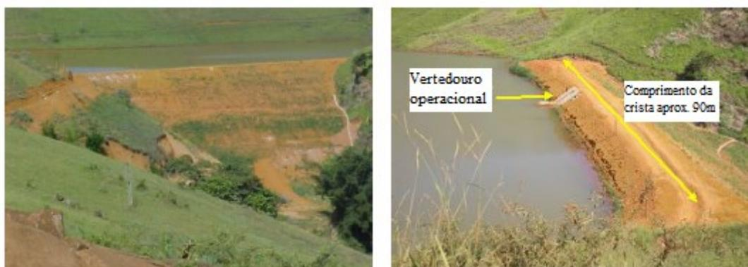
**Figura 5.2:** Vista da crista e do talude a jusante do reservatório São Francisco
