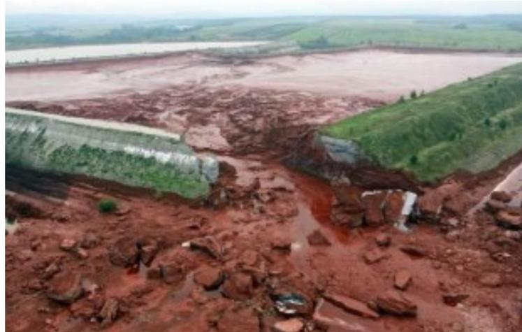
**Figura 3.4:** Cone de depressão de rejeitos liquefeitos causado pela ruptura da barragem de Kolontár (Hungria) – 2010
