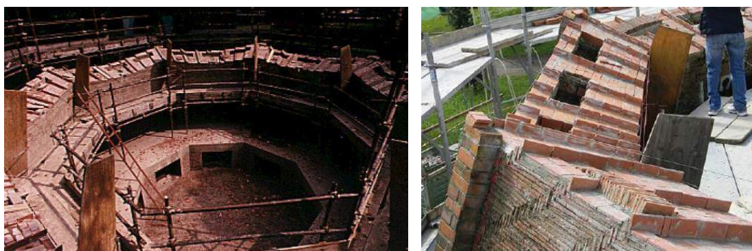
Figura 4 – Reconstituição da construção da cúpula do Duomo por Massimo Ricci.
