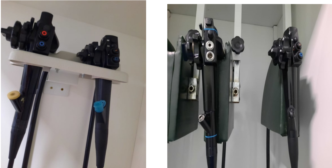
Figura 22 – Registro de acondicionamento inadequado do equipamento, com válvulas acopladas nos endoscópios, em serviços participantes do estudo. Belo Horizonte, Minas Gerais, 2021
