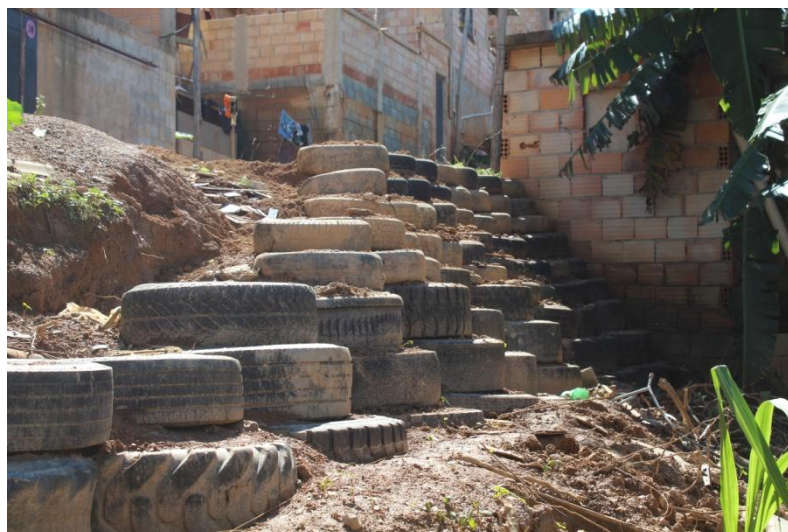
Figura 5: Contenção construída com pneus Fonte: Arquivo do Programa de Extensão Natureza Política
