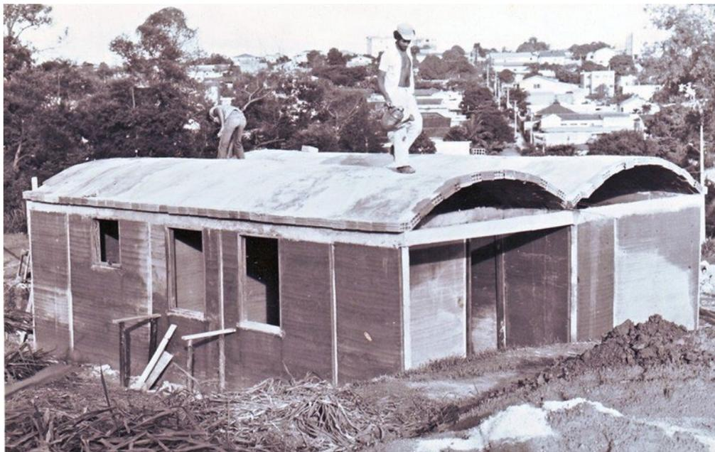
**Desenvolvimento de sistema construtivo com paredes em solo-cimento e cobertura em abóbadas**
