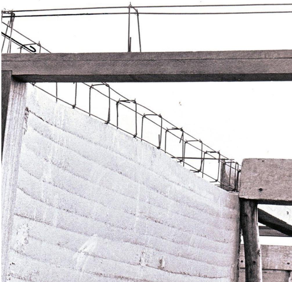
Em todos os referidos tipos de cintas de contraventamento, será sempre conveniente que os vergalhões que compõem sua armadura – em particular no caso da armadura longitudinal – seja contínua, abrangendo todo o seu comprimento.
