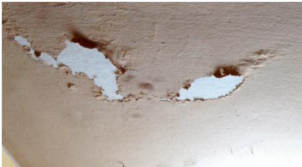
Figura 7 - Descascamento
