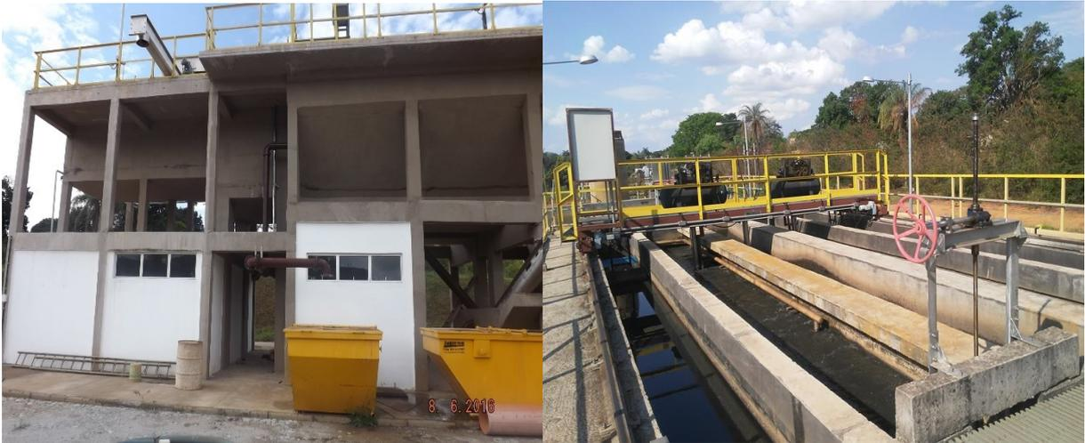
**Figura 4.6:** Vista geral do Sistema Preliminar e da parte superior da caixa de areia aerada
