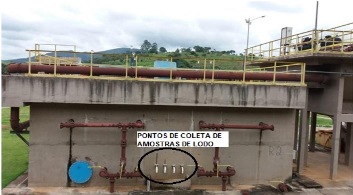
**Figura 4.15:** Vista do reator UASB com indicação dos pontos de coleta de amostras de lodo anaeróbio.
