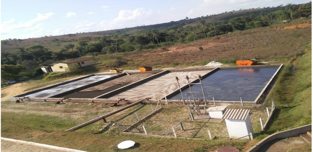
**Figura 4.14:** Vista geral dos leitos de secagem
