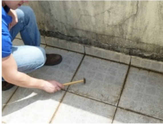
Figura 32 – Inspeção via percussão em piso cerâmico
