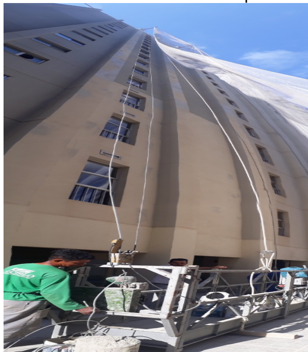
Figura 48 - Plataforma de trabalho utilizada pelos trabalhadores
