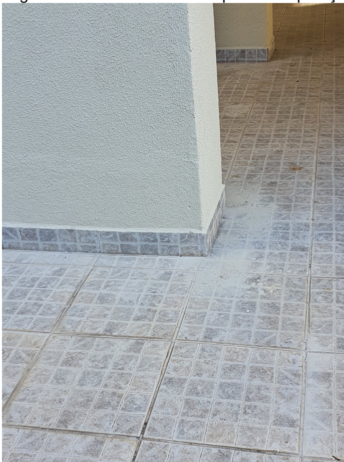
Figura 69 - Base dos Pilares após a recuperação
