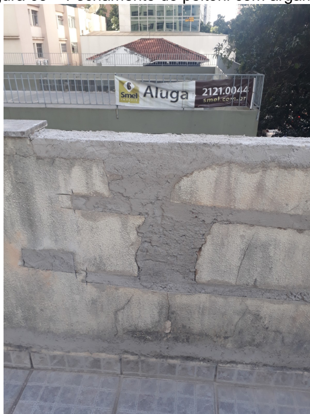
Figura 63 – Fechamento do peitoril com argamassa
