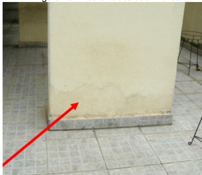
Figura 43– Pés e bases dos Pilares
