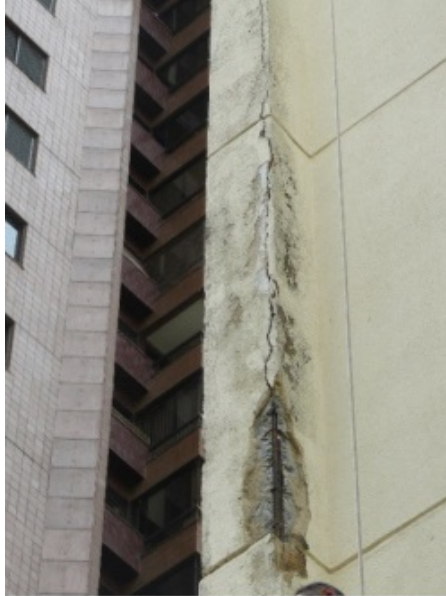
Figura 35 – Pilar da fachada lateral direita
