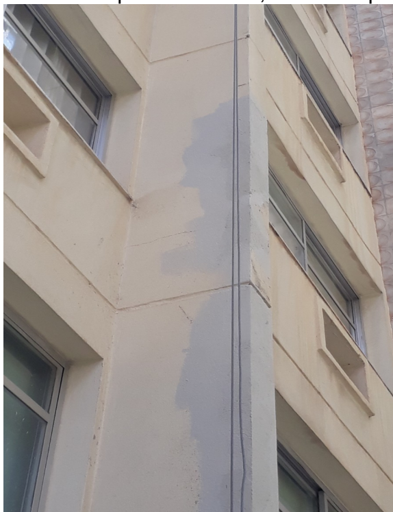
Figura 57 – Fachada quase acabada, faltando apenas pintura
