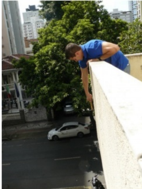
Figura 31 – Inspeção via percussão em peitoril
