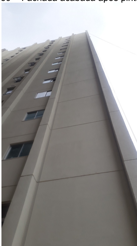
Figura 59 – Fachada acabada após pintura final
