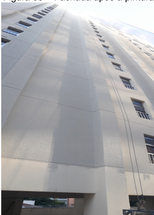
Figura 58 – Fachada após a pintura
