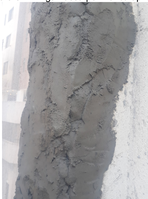
Figura 51 – Argamassa polimérica aplicada
