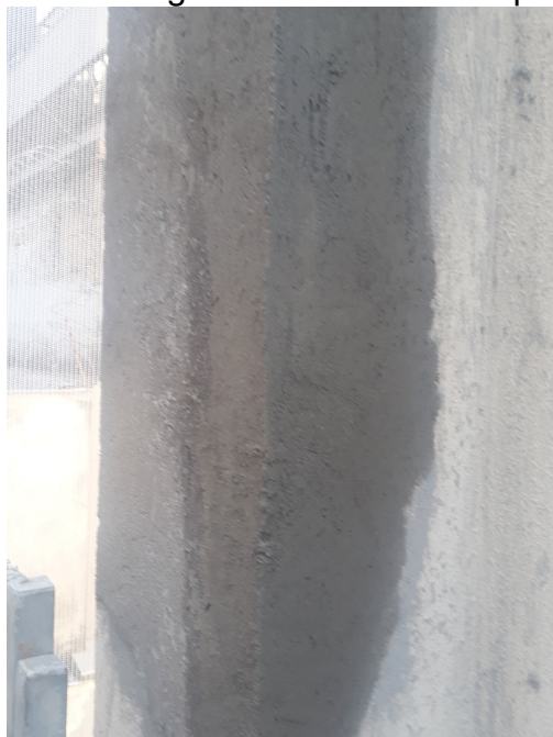
Figura 52 - Argamassa Polimérica aplicada
