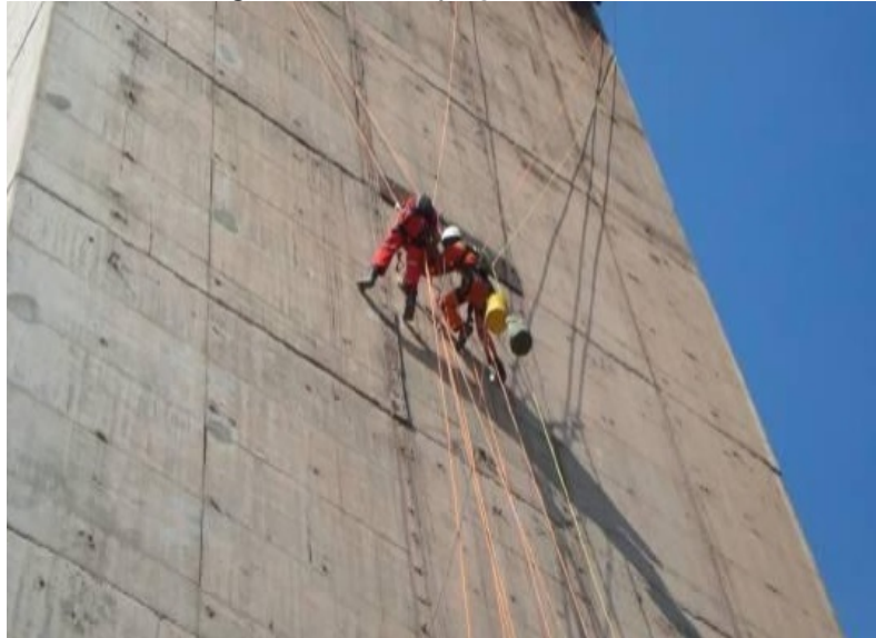
Figura 26 – Inspeção em altura
