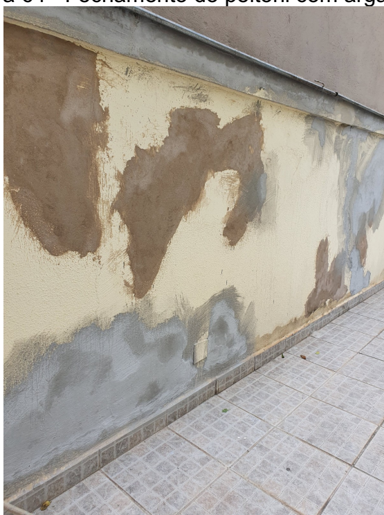
Figura 64– Fechamento do peitoril com argamassa
