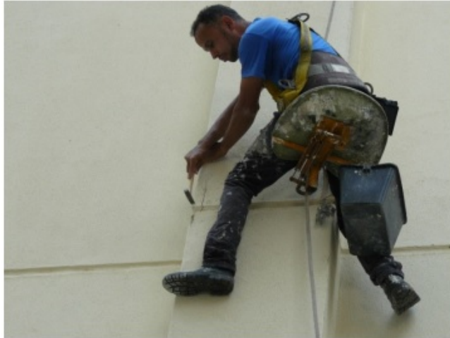
Figura 30 – Inspeção percussiva realizada na fachada
