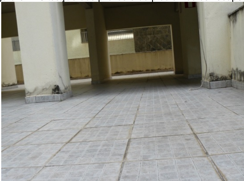
Figura 67 - Situação dos pilares e do piso antes da recuperação
