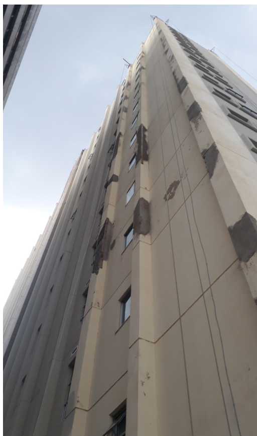
Figura 53 – Argamassa aplicada na fachada
