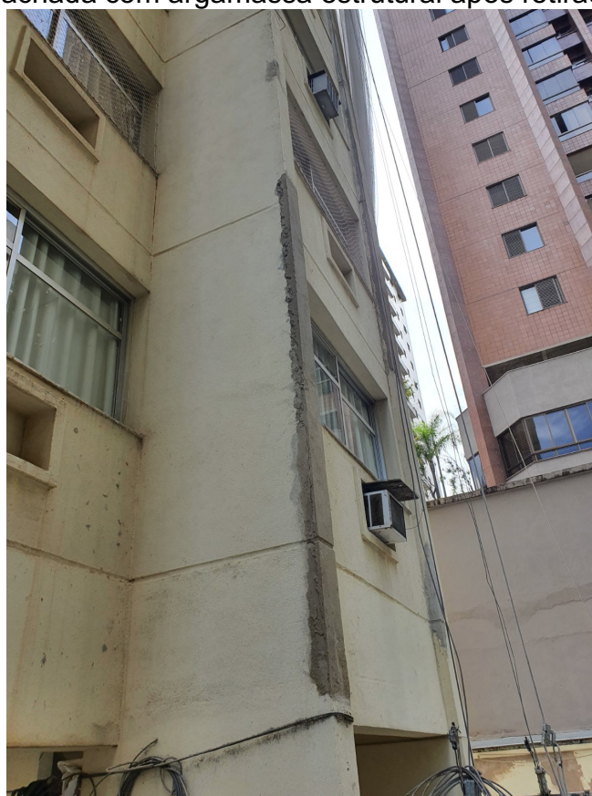
Figura 56 - Fachada com argamassa estrutural após retirada das formas
