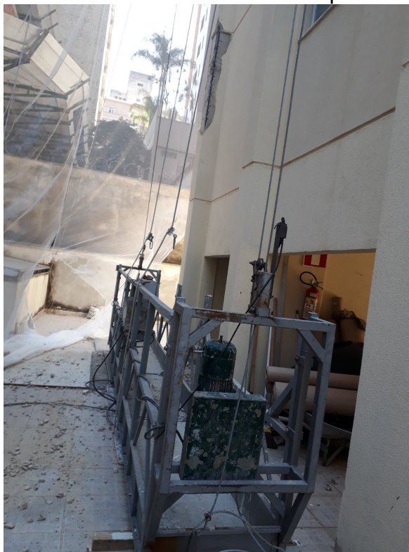
Figura 47 - Plataforma de trabalho utilizada pelos trabalhadores
