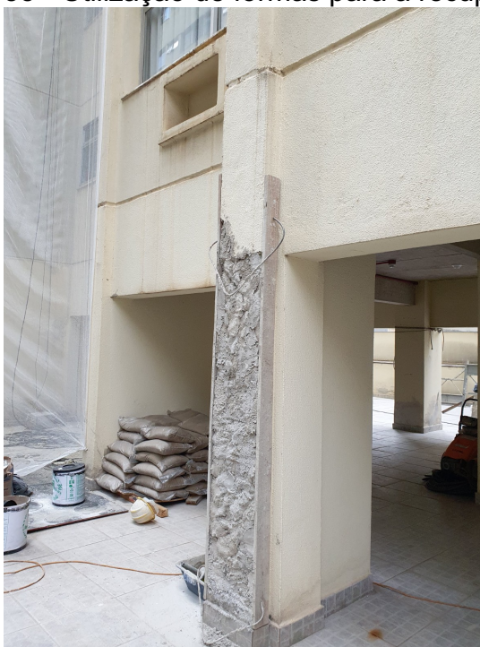
Figura 55 - Utilização de formas para a recuperação
