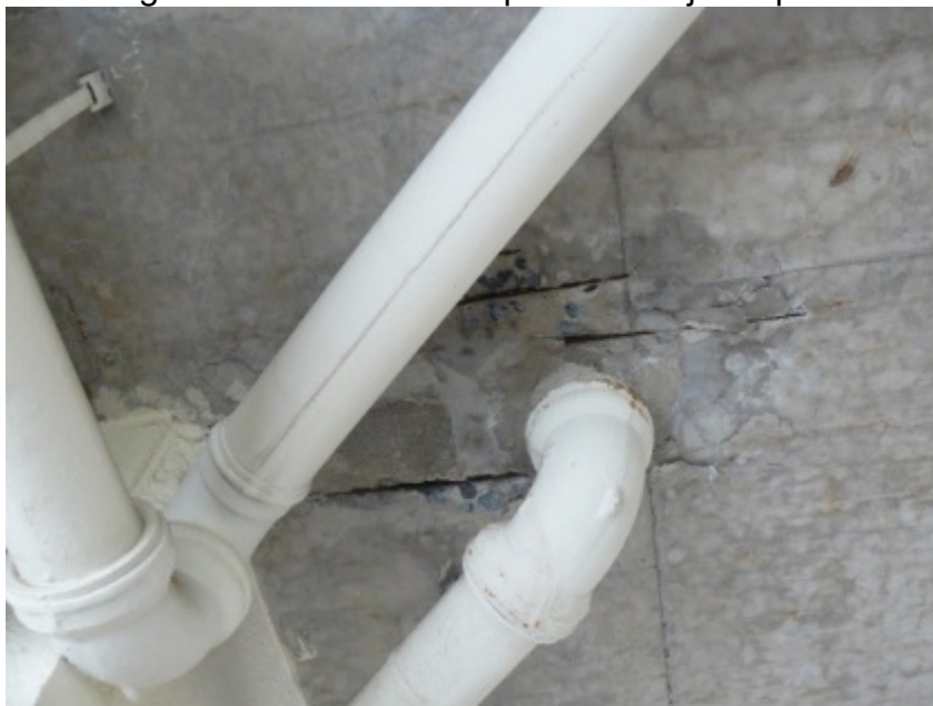
Figura 40 – Armadura exposta em laje do pilotis
