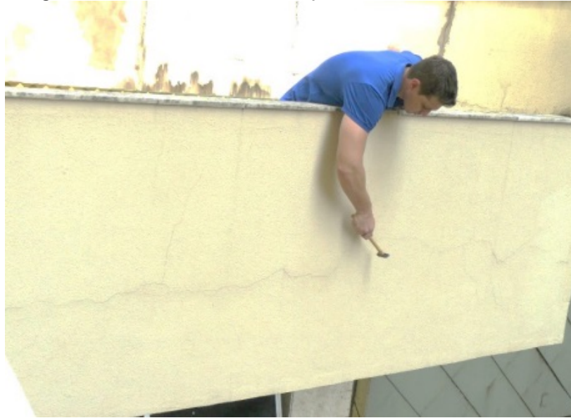
Figura 39 – Peitoril ao fundo próximo ao muro de divisa
