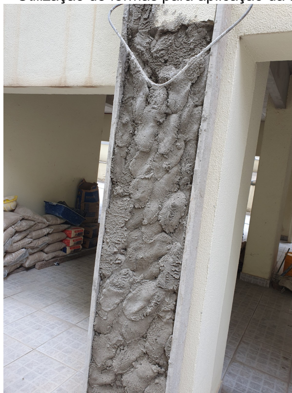
Figura 54 – Utilização de formas para aplicação da argamassa
