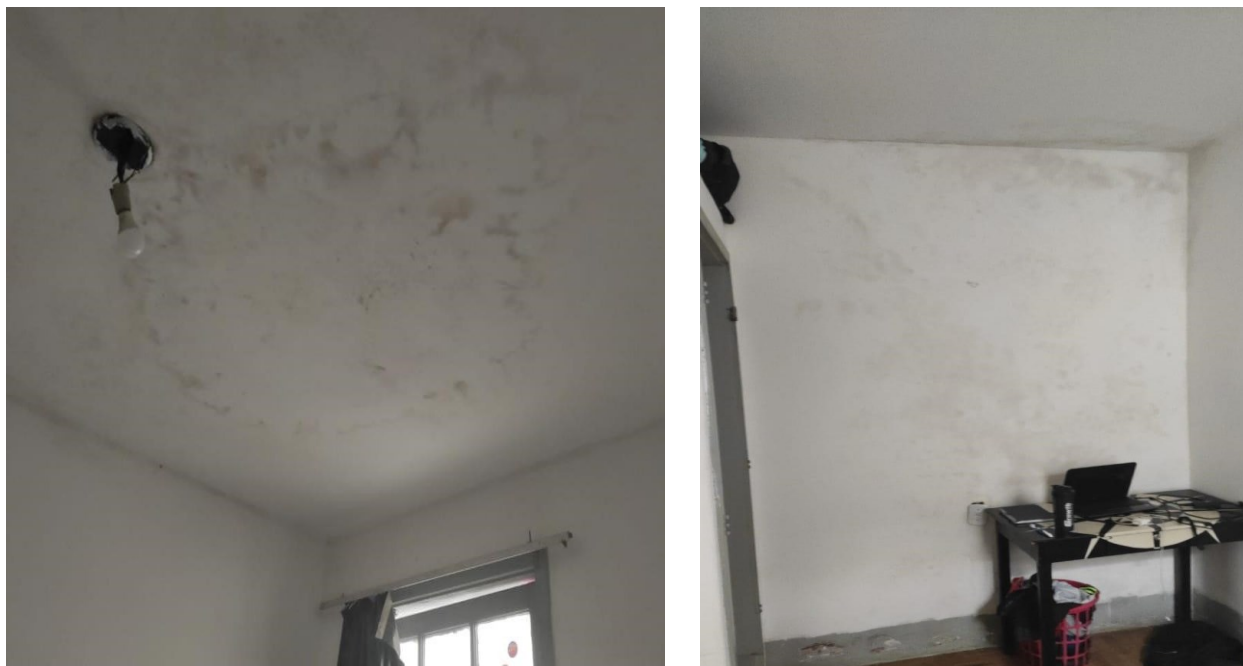
Figura 23 - Teto e parede mofada em um dos quartos da república
