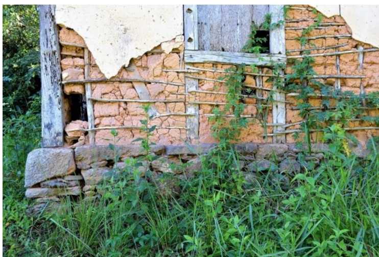
Figura 5 – Parede de pau a pique sobre fundação de pedra
