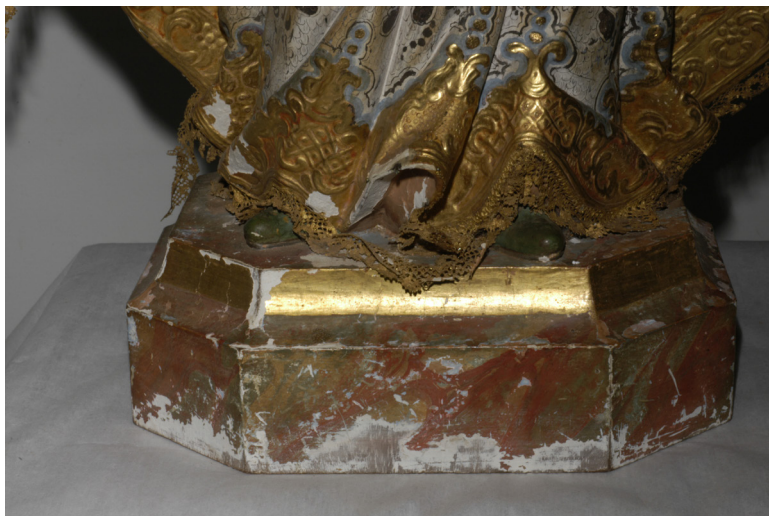
Figura 14 – Detalhe da área de lacunas na base da escultura. Nossa Senhora das Mercês. São Gonçalo do Rio Abaixo, Minas Gerais. Crédito: Maria Regina Emery Quites.
