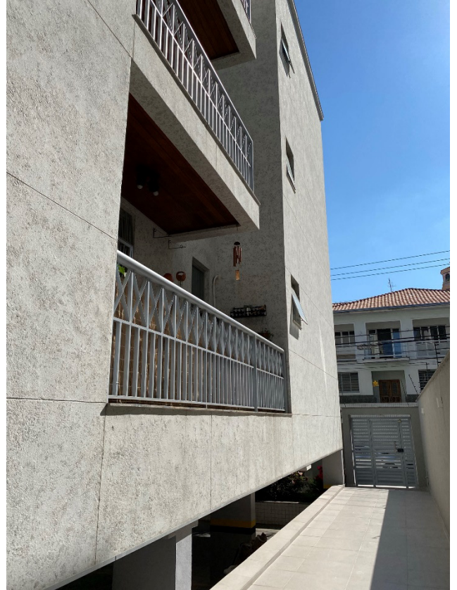
Figura 20 - Foto do edifício após a reforma. Fonte: Autorial.
