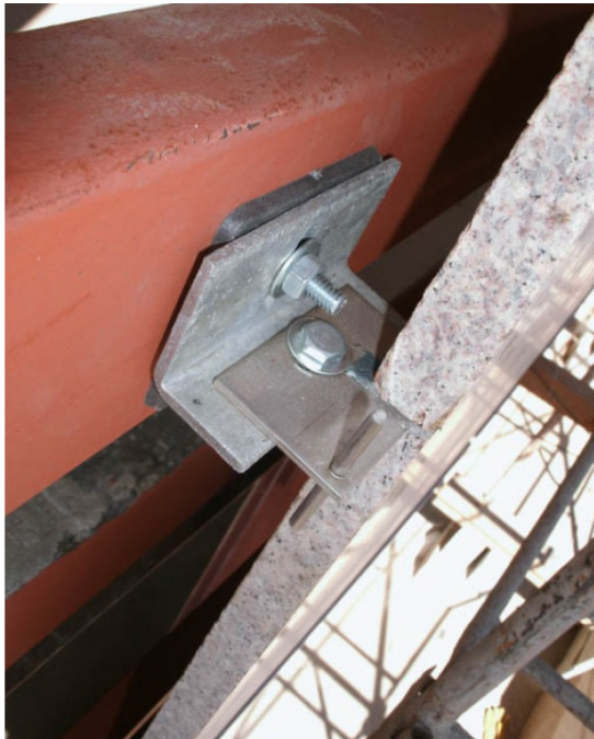
Figura 8 – Fixação granito por inserts. / Fonte: Portal Martins Inserts.
