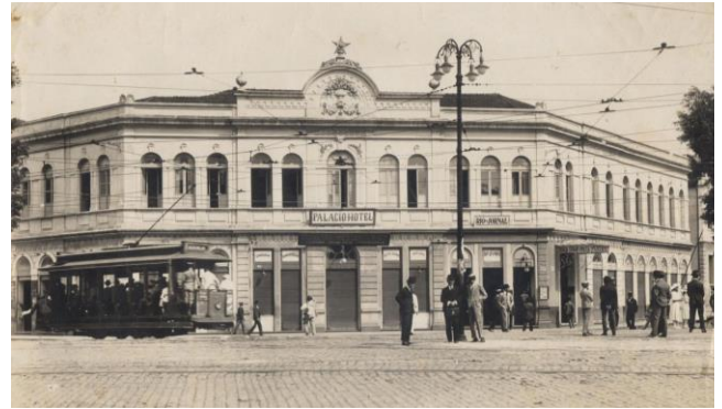
Figura 11- Fachada do Antigo Palácio do Congresso. Data provável 1920
