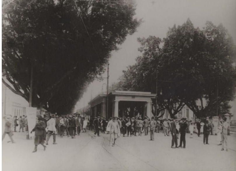
Figura 21- Terminal de bondes circular construído na Praça Sete de Setembro em 1936.
