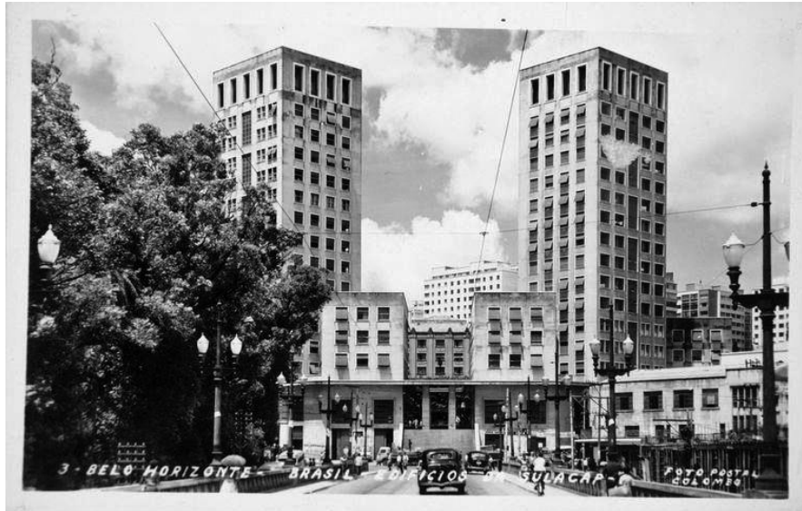
Figura 48- Conjunto Sulacap Sulamérica visto a partir do viaduto Santa Tereza
