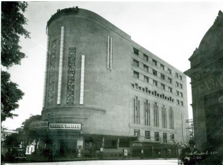
Figura 18-Prédio do Cine Brasil. Década de 1930.
