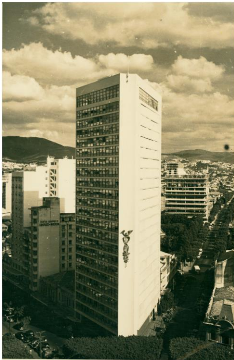
Figura 27- Edifício Clemente Faria, década de 1950
