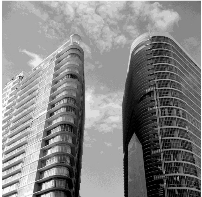
Figura 28- Edifício Banco Mineiro de Produção à direita e edifício Helena Passig à esquerda.
