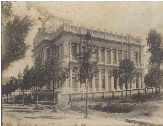
Figura 10- Palácio da Justiça, fachada lateral voltada para a Praça da República. Data provável década de 1910.
