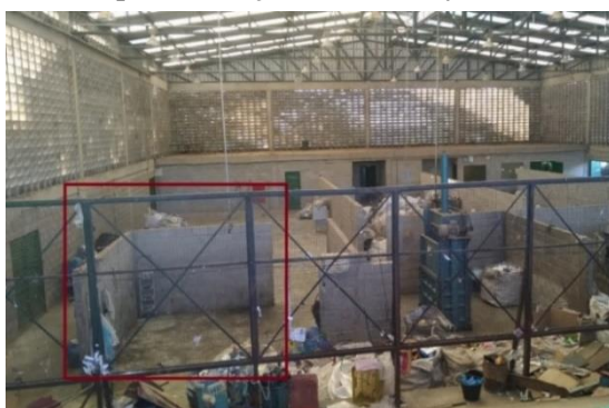
Figura 14 - Paredes (sinalizadas) retiradas para obtenção do novo layout.
