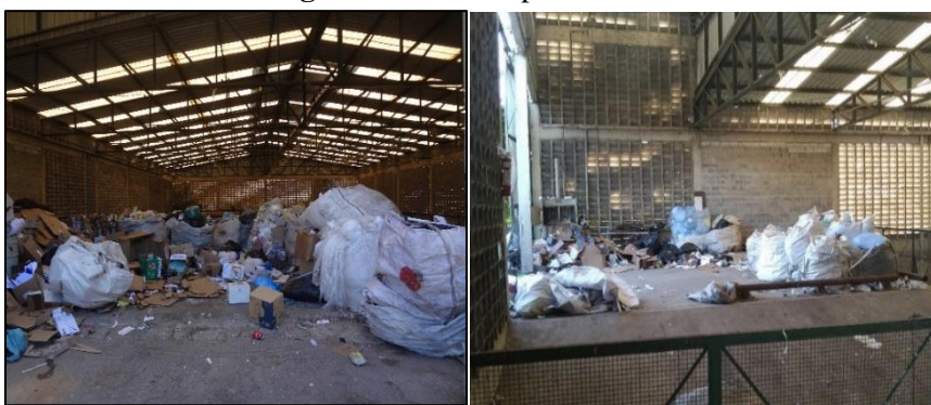
Figura 6 – Parte superior do silo.
