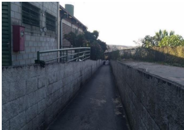
Figura 18 - Rampa que dá acesso ao setor de triagem, à cantina e ao banheiro.
