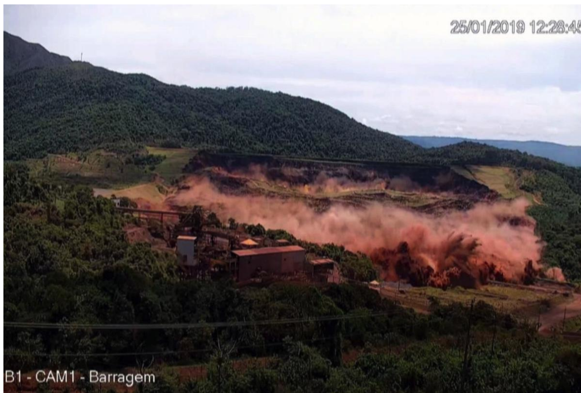
Figura 3 - O exato momento do rompimento da B1.
