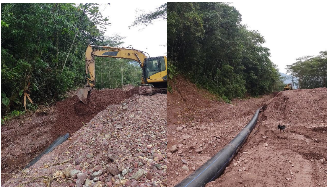
Figura 23: Instalación de tubería subfluvial en el lecho del río Guatiquía (2021)
