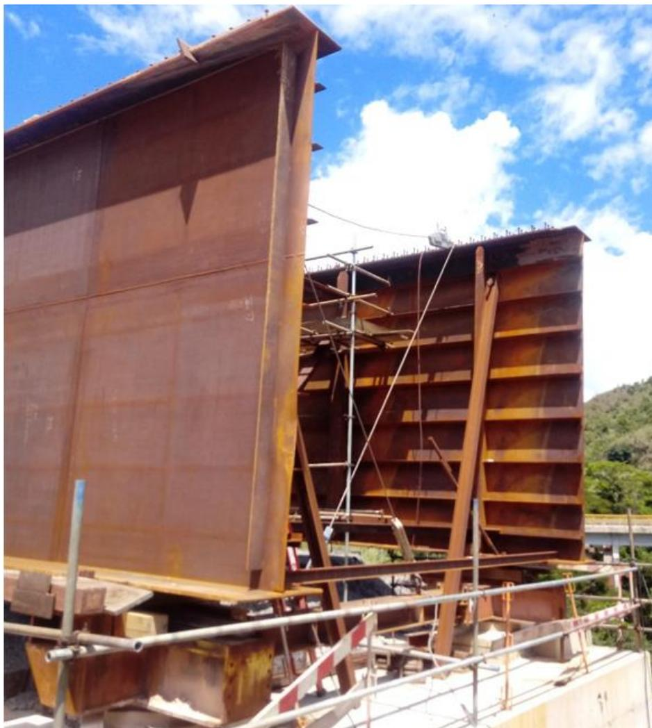
Figura 1.2: Construção da Ponte Ribeirão Severo I, em Antônio Dias - MG, utilizando elementos de aço enrijecidos. Fonte: RMG Engenharia.
