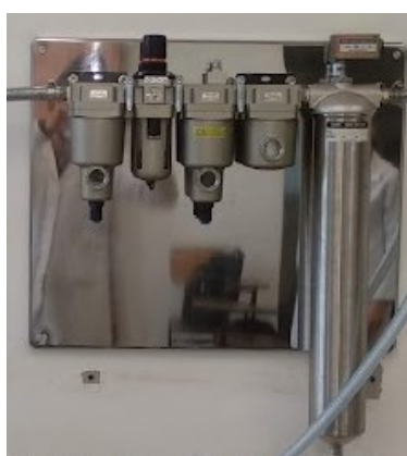
Figura 20. Filtro de linha utilizados para purificar ar comprimido
