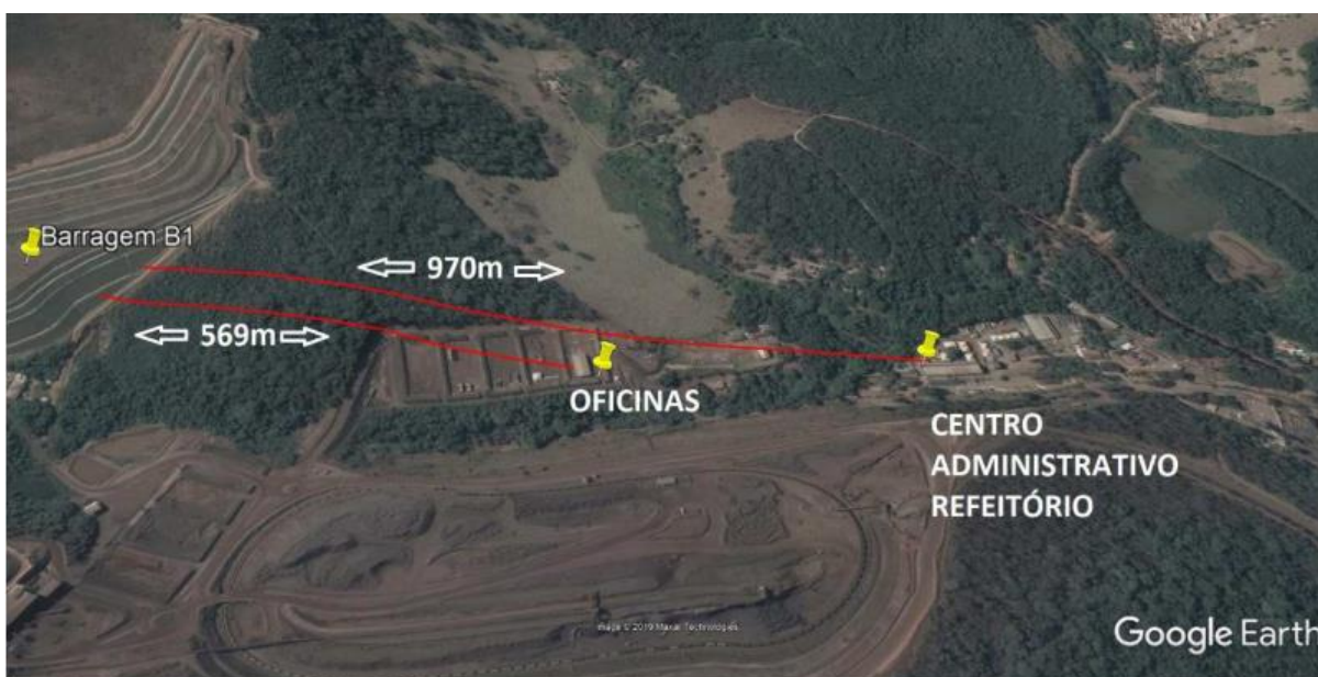
Figura 50 - Distância entre a barragem B1 e as instalações do complexo minerário Córrego do Feijão
