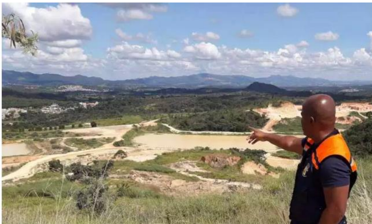
Figura 96 - Barragem Dique D localizada em Betim
