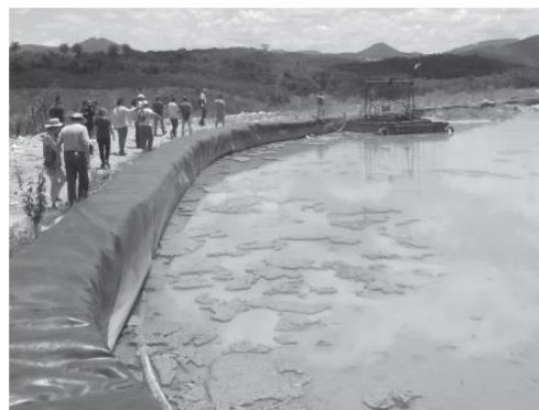
Uma das barragens da Mundo Mineração está totalmente cheia, quase transbordando, com marcas de erosão nos diques.
