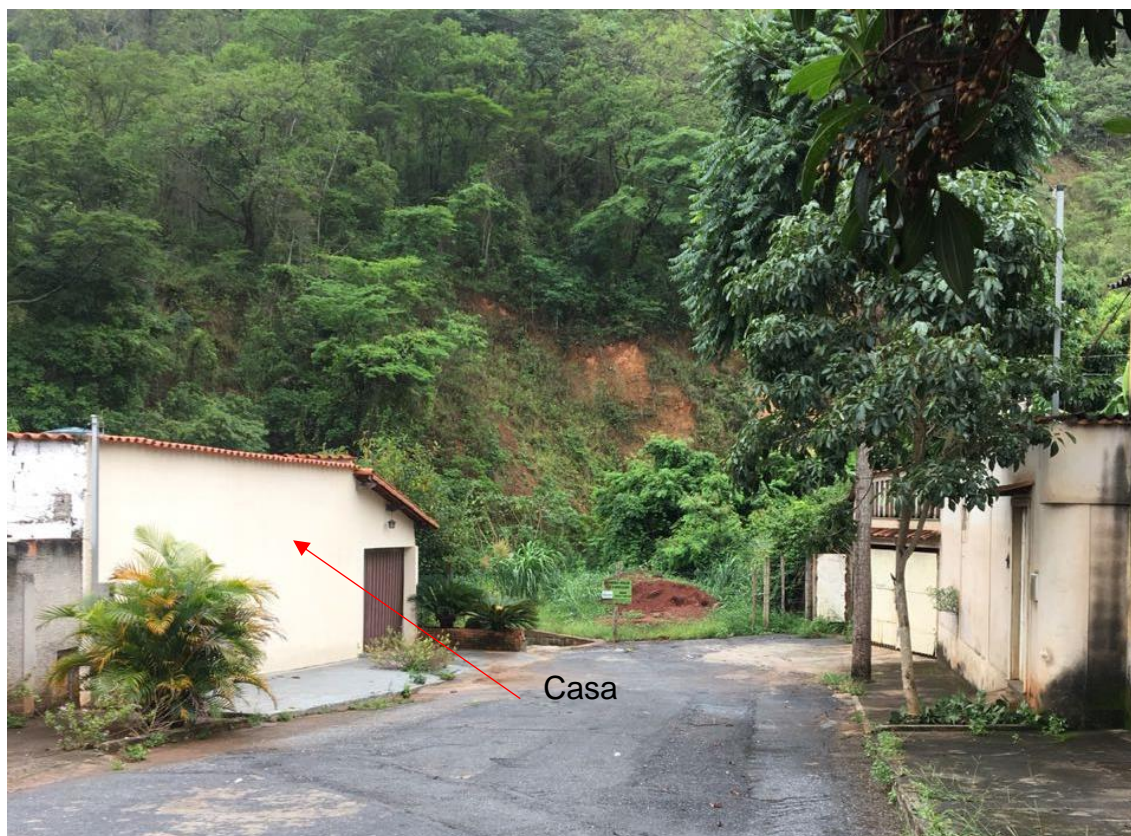
Figura 5 - Vista da rua de acesso para a Casa.
