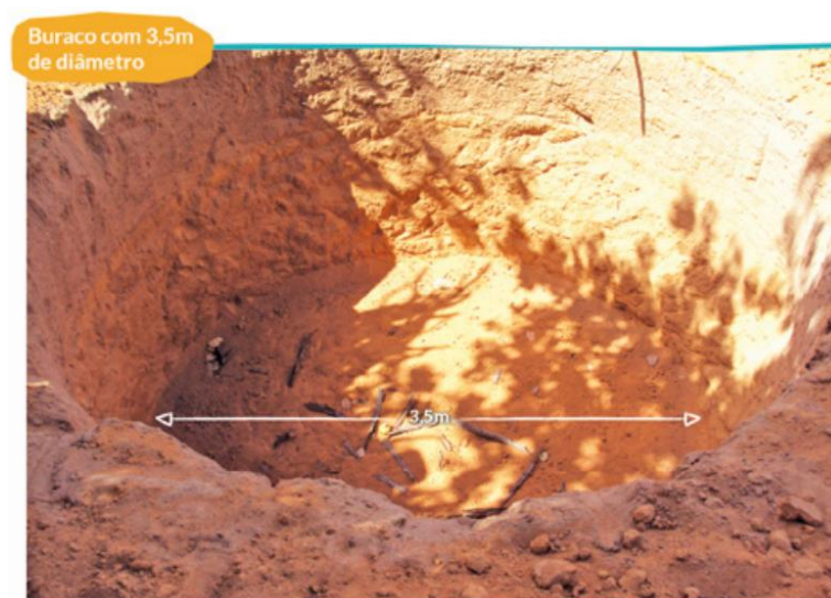
Figura 18- Escavação para instalar o biodigestor
