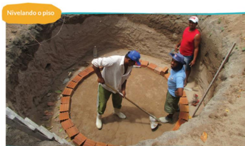
Figura 20- Nivelando o piso
