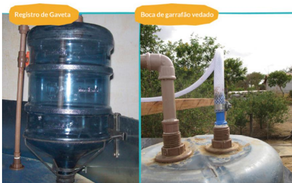
Figura 31- Instalação dos canos no garrafão
