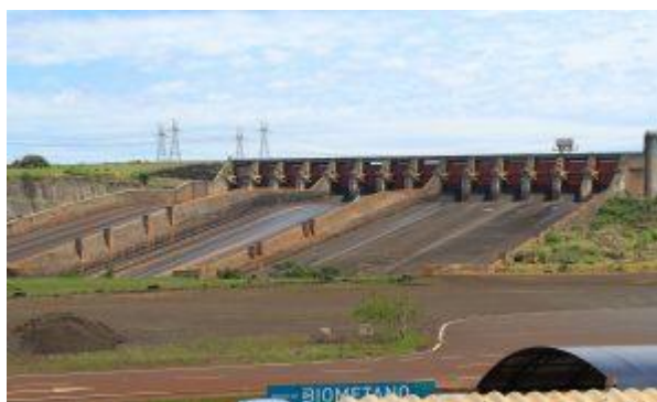
Figura 8- Barragem de Itaipu, Foz do Iguaçu (PR)
