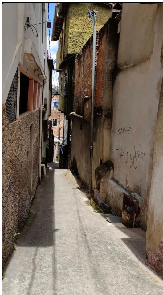
Figura 27: Beco de circulação na Pedreira Prado Lopes
