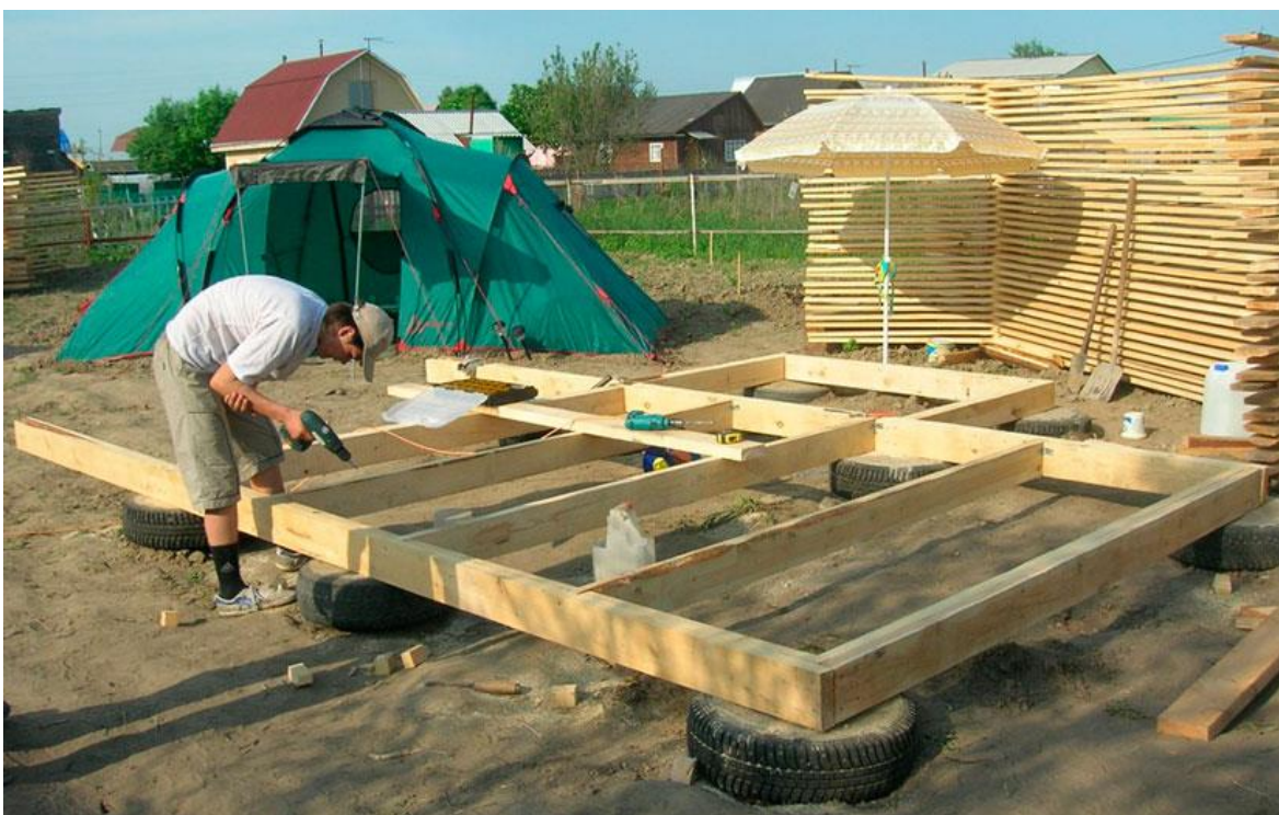
Figura 23: Fundação de Casa de Madeira - Utilização de pneus
