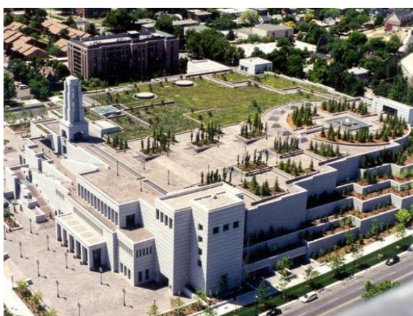
Figura 2: Telhado verde intensivo do LDS Assembly Hall - Salt Lake City, Utah. Fonte: (MARTINS, 2010).
