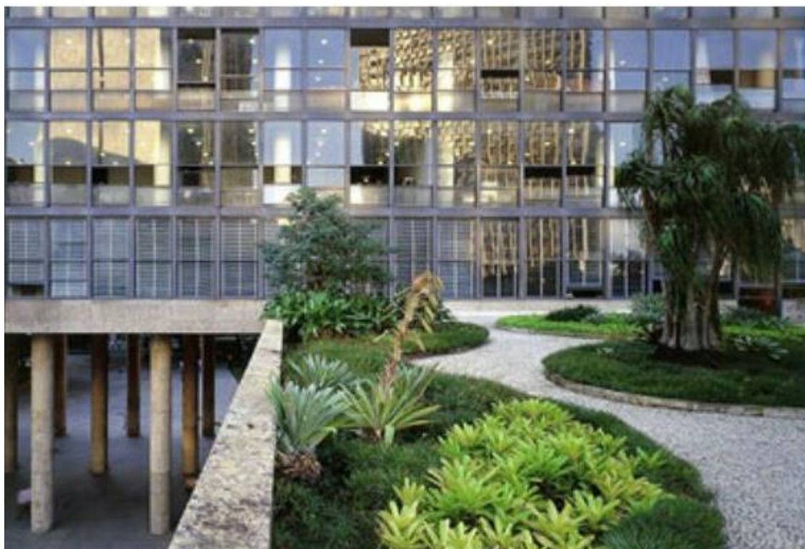
Figura 9: Telhado Verde do Palácio Gustavo Capanema (Edifício do MEC), Rio de Janeiro. Fonte: (ROLA, 2008).
