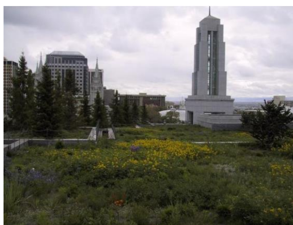
Figura 3: Detalhe do telhado verde do LDS Assembly Hall - Salt Lake City, Utah. Fonte: (MARTINS, 2010).
