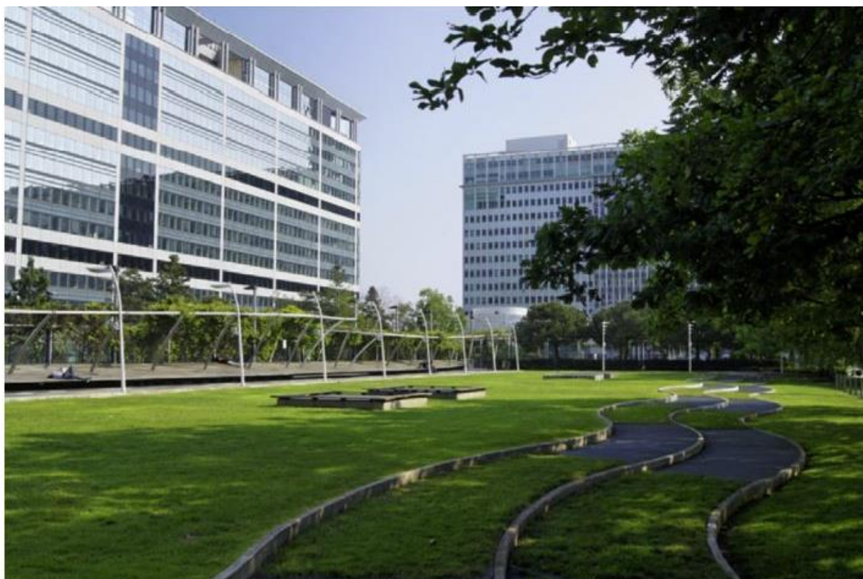
Figura 15: Telhado verde acima da Gare Monparnesse. Fonte: (KOTZEN, 2018).
