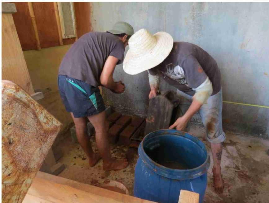
FOTO 16 - Tijolo de adobe sendo produzido em curso de Bioconstrução, Lapinha - Sítio Entoá (2015).
