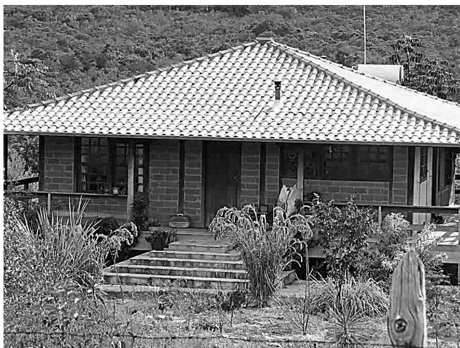
FOTO 15 - Residência de moradora “de fora” construída com tijolo de adobe. São Gonçalo do Rio das Pedras, 2016.
