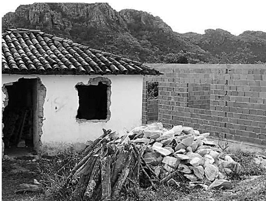
FOTO 14 - Casa de adobe de antigo morador sendo demolida (à esquerda); casa de tijolo industrial sendo construída (à direita). São Gonçalo do Rio das Pedras, 2016.
