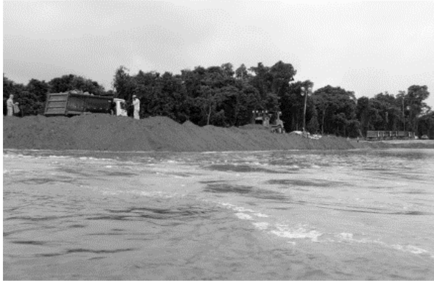
Figura 11 – Lançamento das ensecadeiras. Foto: João Zinclar. Fonte: Sposati (2012).
