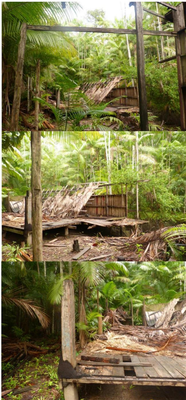
*Figura 11 - Parte da casa, vista externa esquerda, que interligava a sala, o quarto e a cozinha. A estrutura da cozinha e da sala era formada com 3 esteios laterais, um de cada lado, com uma distância em geral de dois metros entre eles. E o telhado estilo duas águas, que na sala era de brasilit e, atrás na cozinha, de palha. Fechando um retângulo em todo o espaço da casa.*
