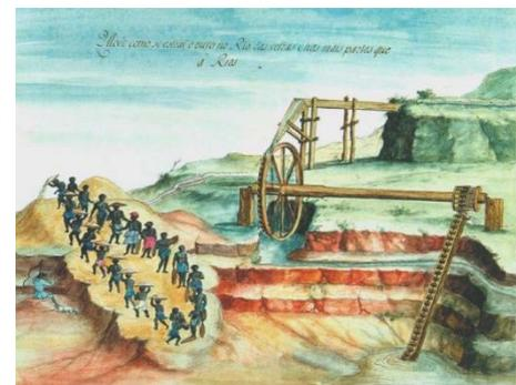
Figura 10: tecnologias auríferas coloniais: a) *Representação ou perfil de hum servº. que fazendo agua se esgota por pias, e a força de braços*; b) *Modo como se extrai o ouro no Rio das velhas, e nas mais partes que á Rios*.
