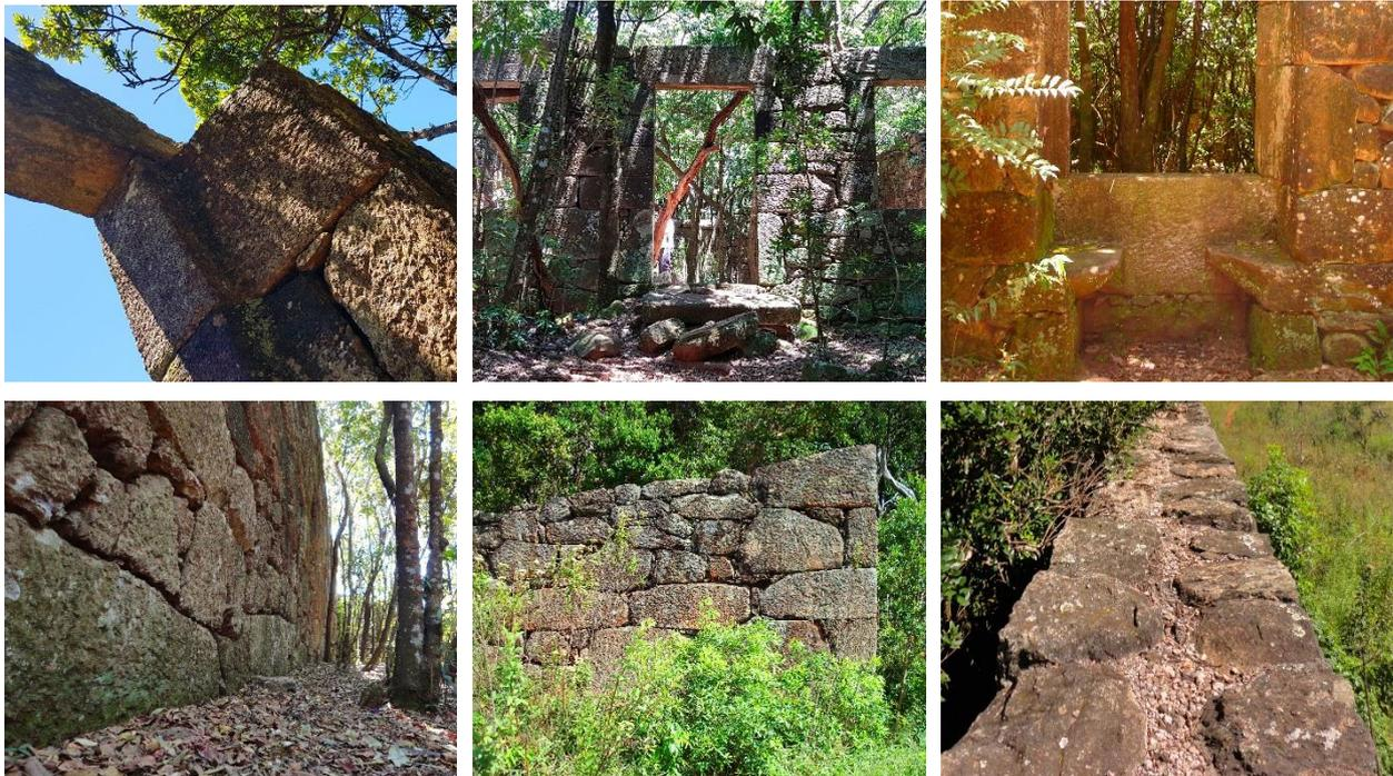
Figura 8: as ruínas do *Forte de Brumadinho*: a) detalhe da verga e ombreira do portal, em 2019; b) frontaria da edificação principal, em 2019; c) conversadeiras de janelão, em 2009; d) face interna da muralha posterior, em 2011; e) detalhe da muralha norte, em 2010; f) o sistema de *alvenaria de duas faces* visto do topo da muralha norte.
