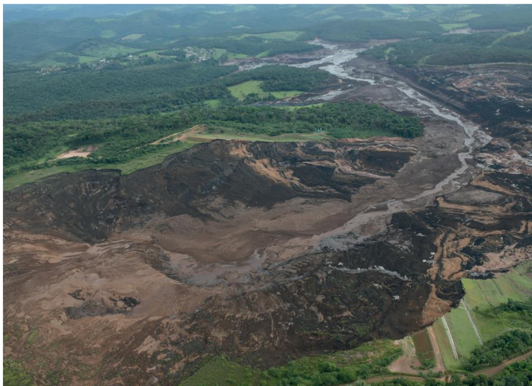
Figura 16 – área da barragem que se rompeu e de abrangência de destruição à jusante
