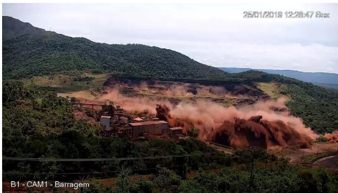
Figura 14 – Momento do rompimento, quando acontece a explosão da barragem
