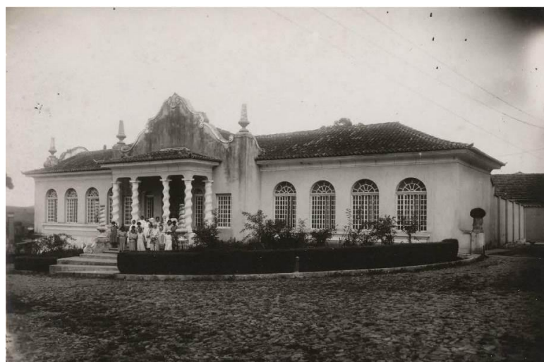
Figura 29 – Pavilhão Antônio Carlos
