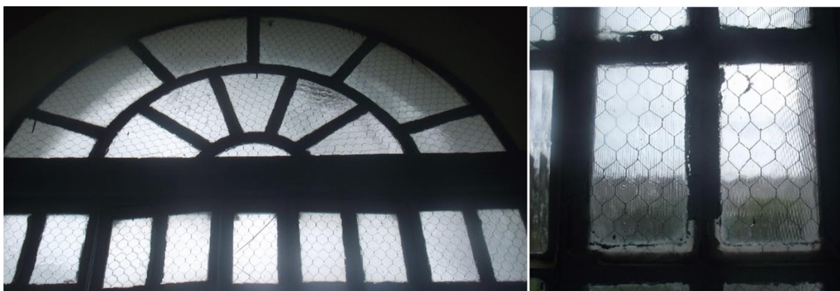
Figura 60 – Detalhes da janela do pavilhão Antônio Carlos
