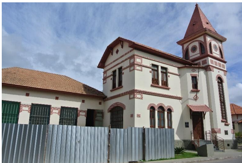
Figura 32 – Torre do Departamento B do Hospital Colônia de Barbacena
