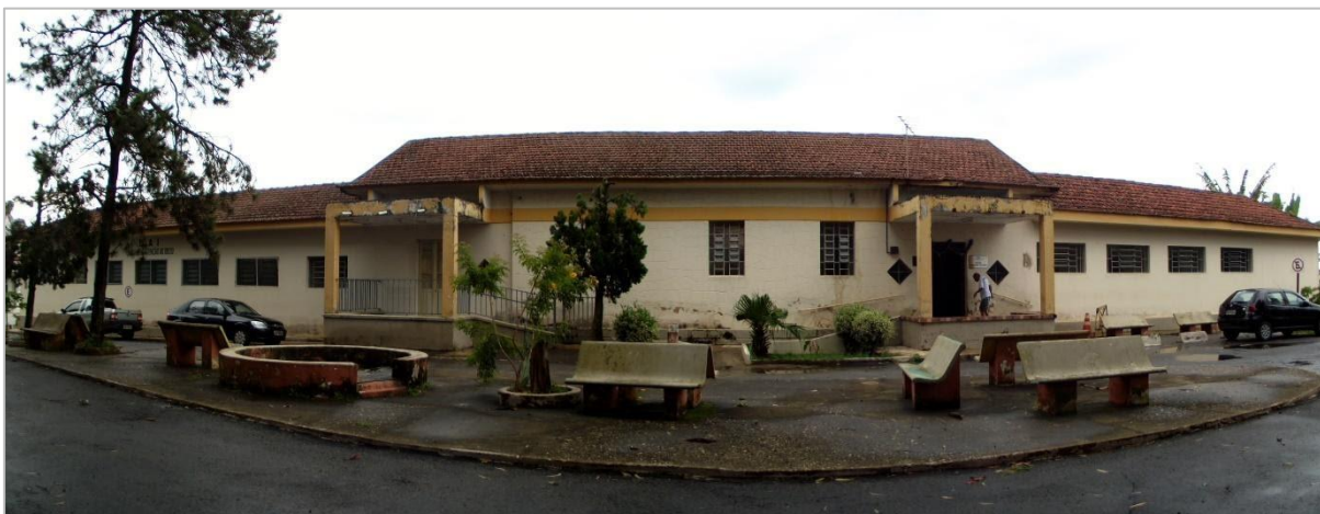
Figura 35 – Pavilhão Governador Valadares
