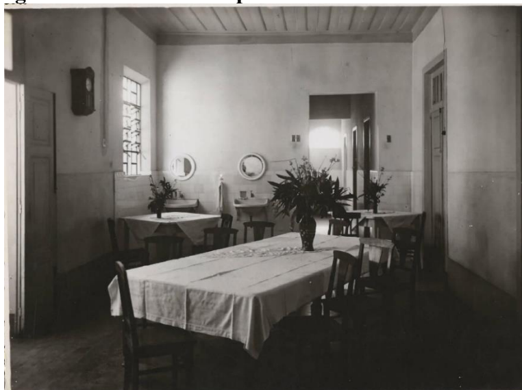
Figura 62 – Refeitório do pavilhão Governador Valadares
