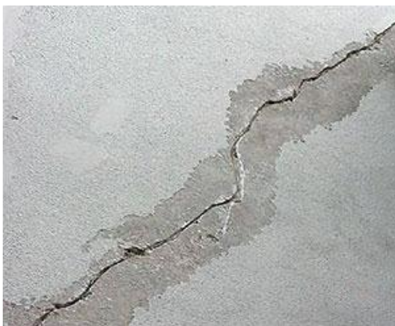
Figura 07: Fissuras geométricas X Fissuras Mapeadas
