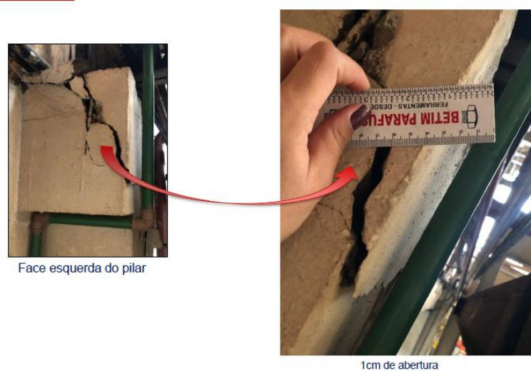
Figura 11: Face esquerda do pilar G1 (1 Medição)
