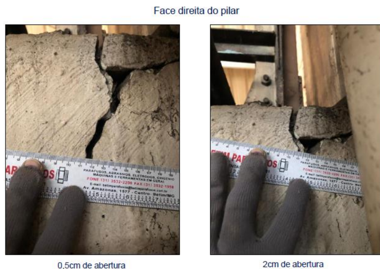
Figura 13: Face direita do pilar G1 (1 Medição)
