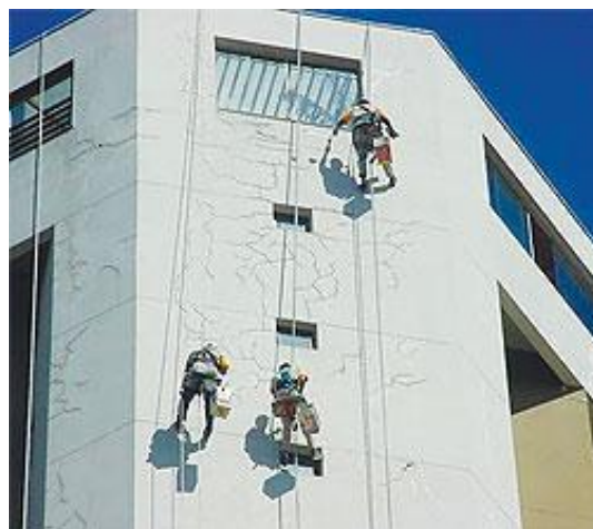
Figura 07: Fissuras geométricas X Fissuras Mapeadas
