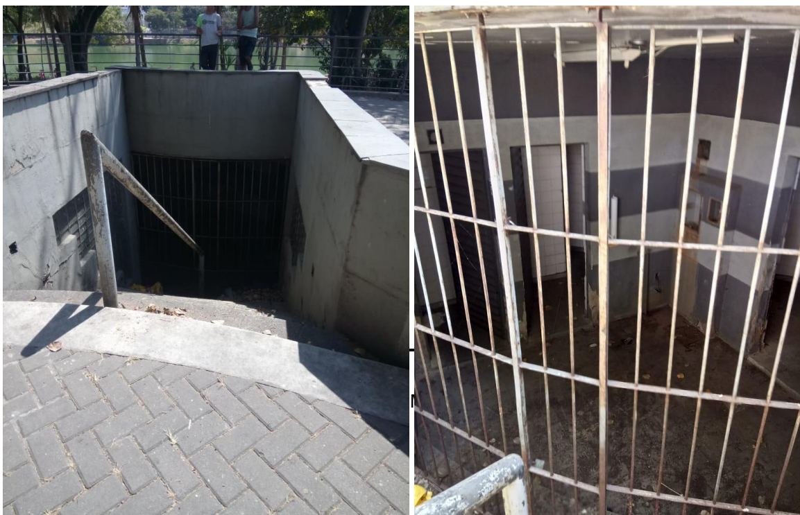
Figura 5: Escadas de acesso ao banheiro subterrâneo (esquerda) e banheiro trancado e descuidado (direita)
