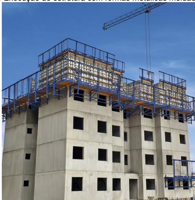
Figura 7: Execução de estrutura com fôrmas metálicas moldadas in loco .
