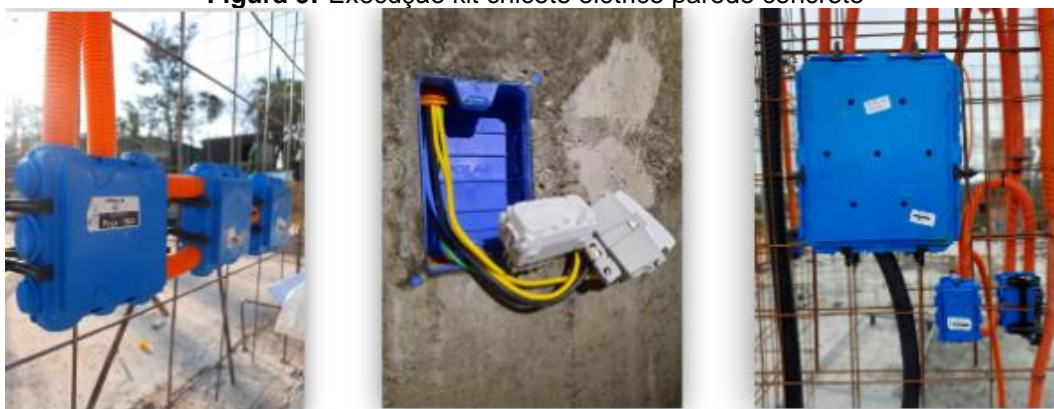
Figura 9: Execução kit chicote elétrico parede concreto
