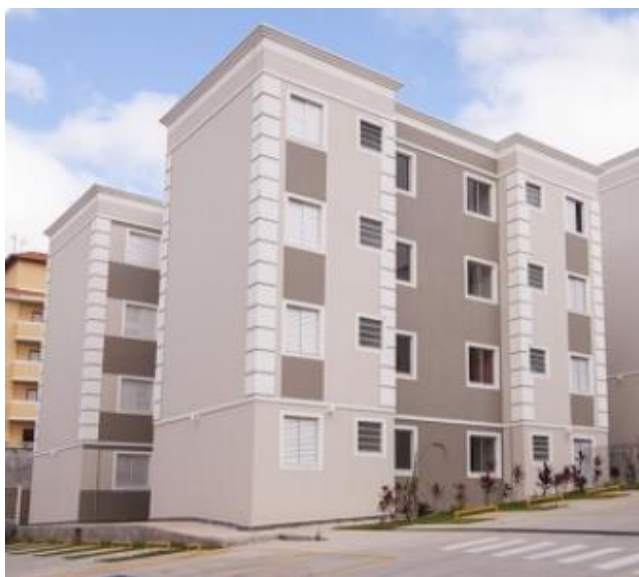
Figura 12: Fachada de bloco - Parque Sevilha MRV Engenharia
