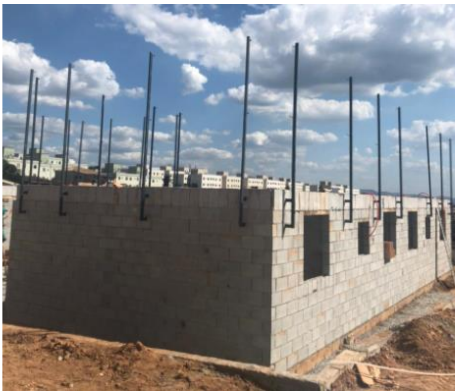
Figura 4: Execução alvenaria estrutural em blocos de concreto
