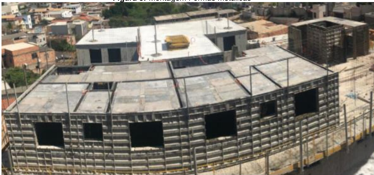
Figura 8: Montagem Fôrmas metálicas
