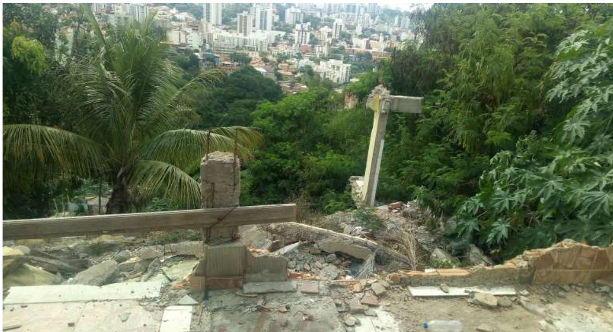
Figura 8: Entulhos na Vila São Bento em 2018 Fonte: Arquivo da autora
