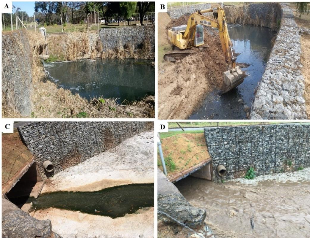
**Figura 32.** Alterações desenvolvidas no trecho do córrego Engenho Nogueira localizado situado dentro da área do campus Pampulha da Universidade Federal de Minas Gerais. (A) Limpeza da área com a retirada de vegetação; (B) Retirada de sedimentos do córrego; (C) Ação finalizada, fluxo do córrego em período de estiagem; (D) Ação finalizada, fluxo do córrego em período de chuva.
