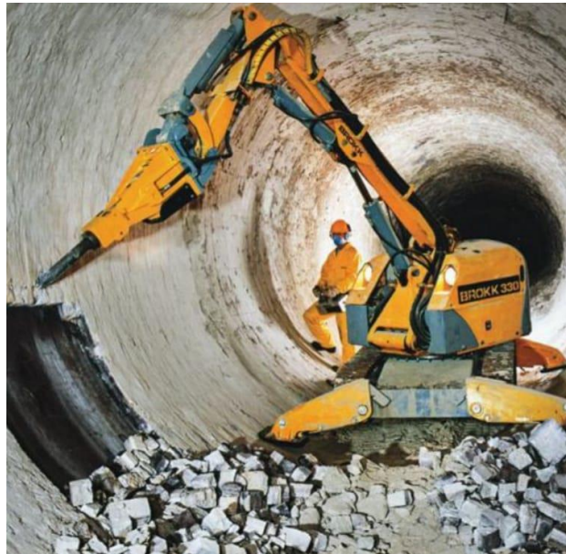
Figura 2 – Concreto refratário em aplicação em forno de clínquer. Fonte: (ARQUIVO PRÓPRIO).
