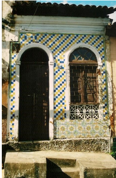
FIGURA 09 – Tipo-base “Porta e Janela” na Rua da Inveja, São Luís, MA
