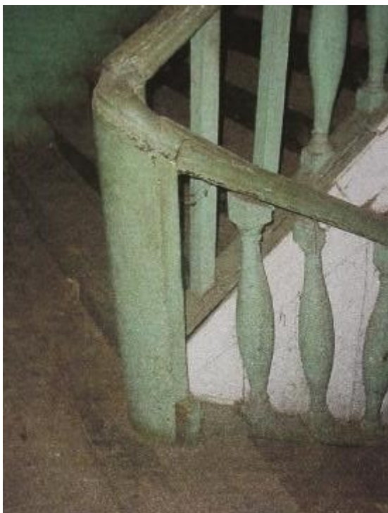
FIGURAS 96 e 97 – Guarda corpo com peças torneadas no Solar dos Belfort, construído em 1756 e no Solar dos Leite, construído em 1829
