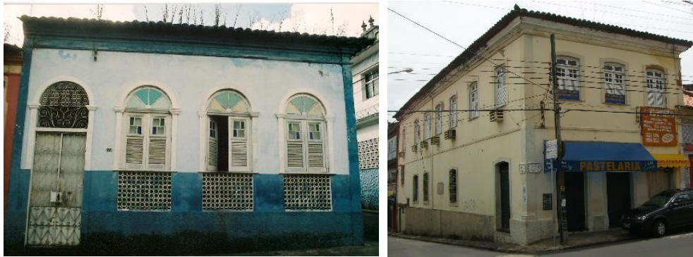
FIGURAS 12 e 13 – “3/4 de Morada” e Sobrado na rua Cândido Ribeiro, São Luís, MA.
