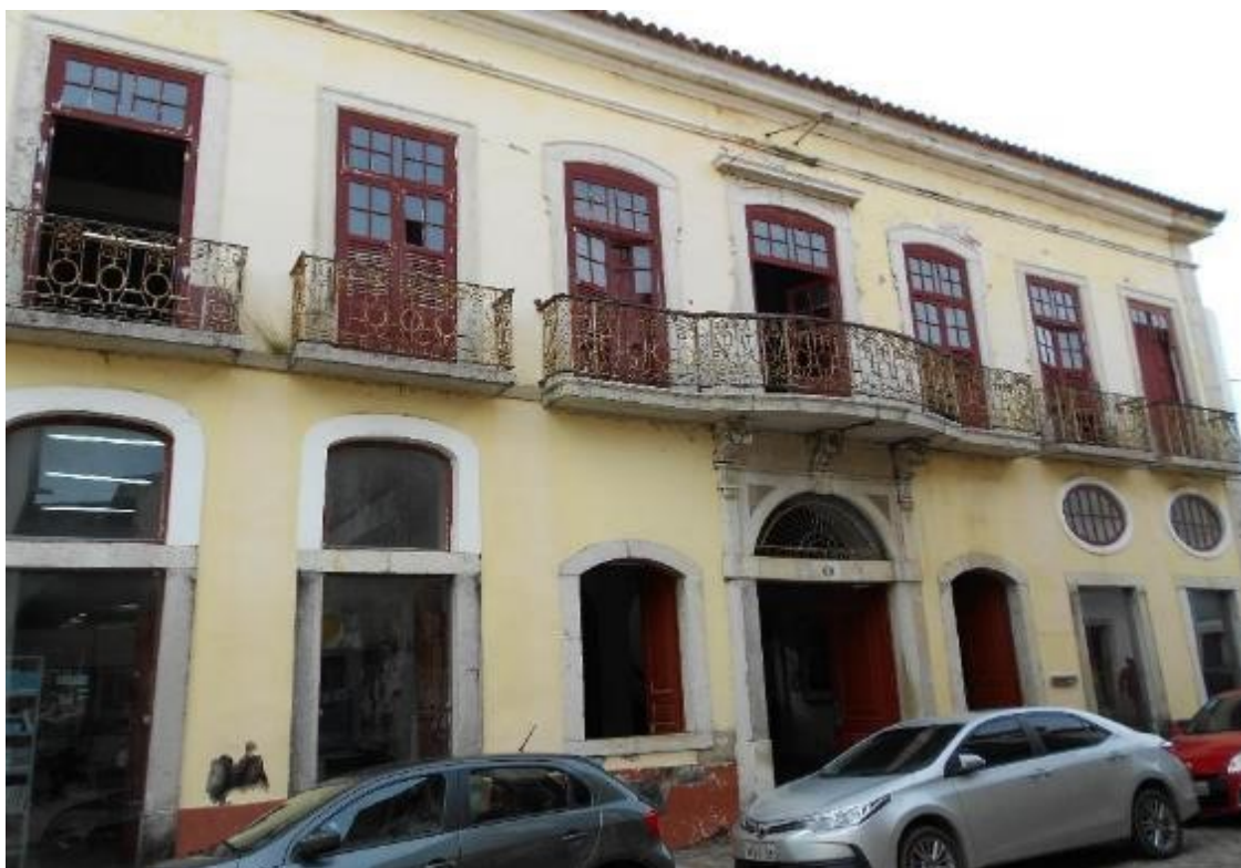
FIGURA 48 - Foto da Fachada do Solar dos Vasconcelos
