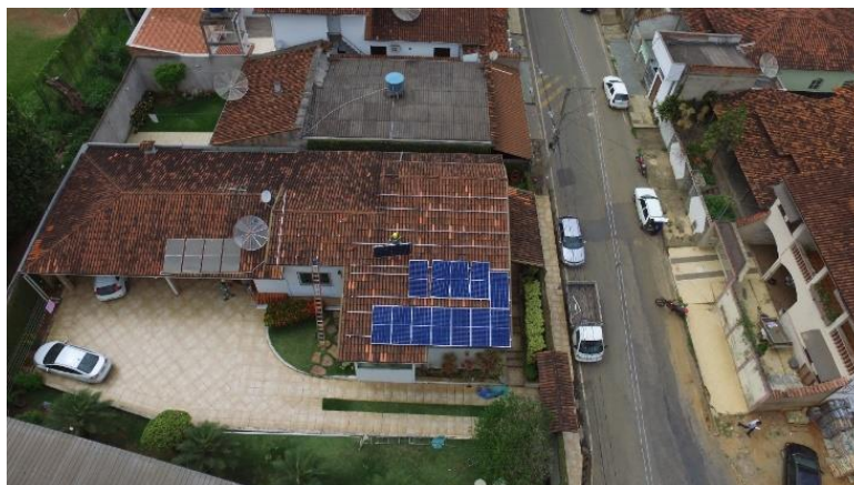
Fotografia 12 – SFV – 28 kWp – Timóteo/MG
