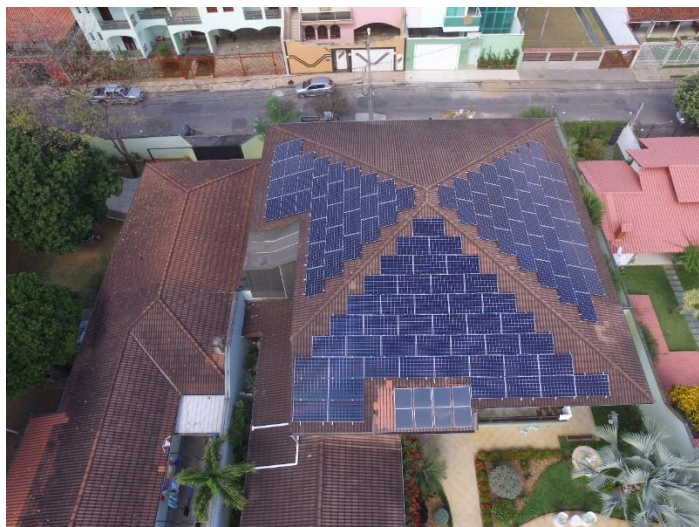
Fotografia 23 – SFV 33 kWp – Ipatinga/MG
