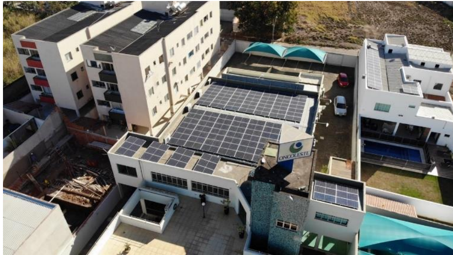
Fotografia 3 – SFV 41,18 kWp – Governador Valadares/MG
