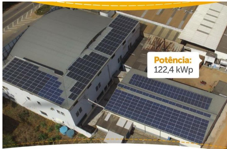
Fotografia 22 – SFV 122,4 kWp – Caratinga/MG
