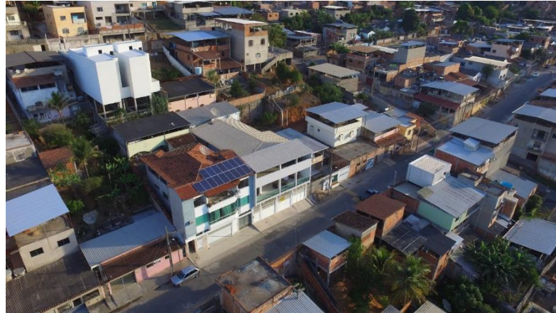
Fotografia 16 – SFV 5,12 kWp – Timóteo/MG
