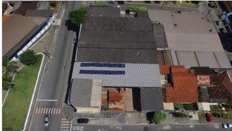
Fotografia 6 – SFV 11,52 kWp – Timóteo/MG
