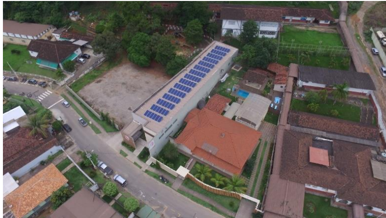
Fotografia 15 – SFV 29,25 kWp – Governador Valadares/MG
