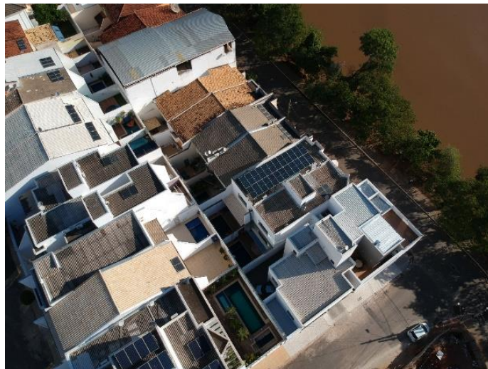
Fotografia 8 – SFV 8,52 kWp – Governador Valadares/MG
