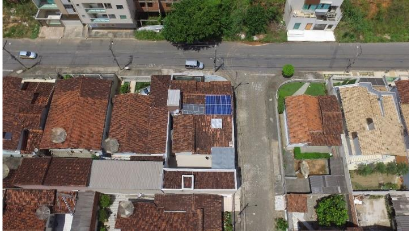
Fotografia 9 – SFV 3,3 kWp – Timóteo/MG
