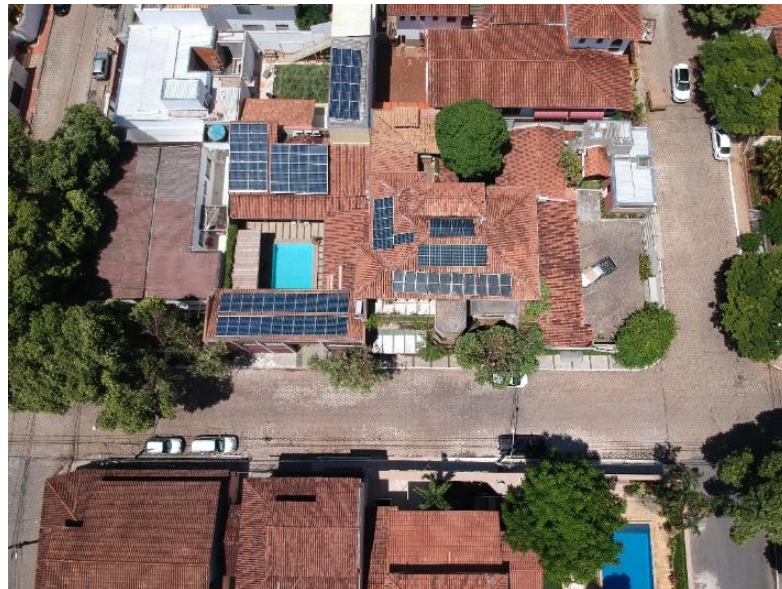
Fotografia 2 – SFV 28,8 kWp – Governador Valadares/MG
